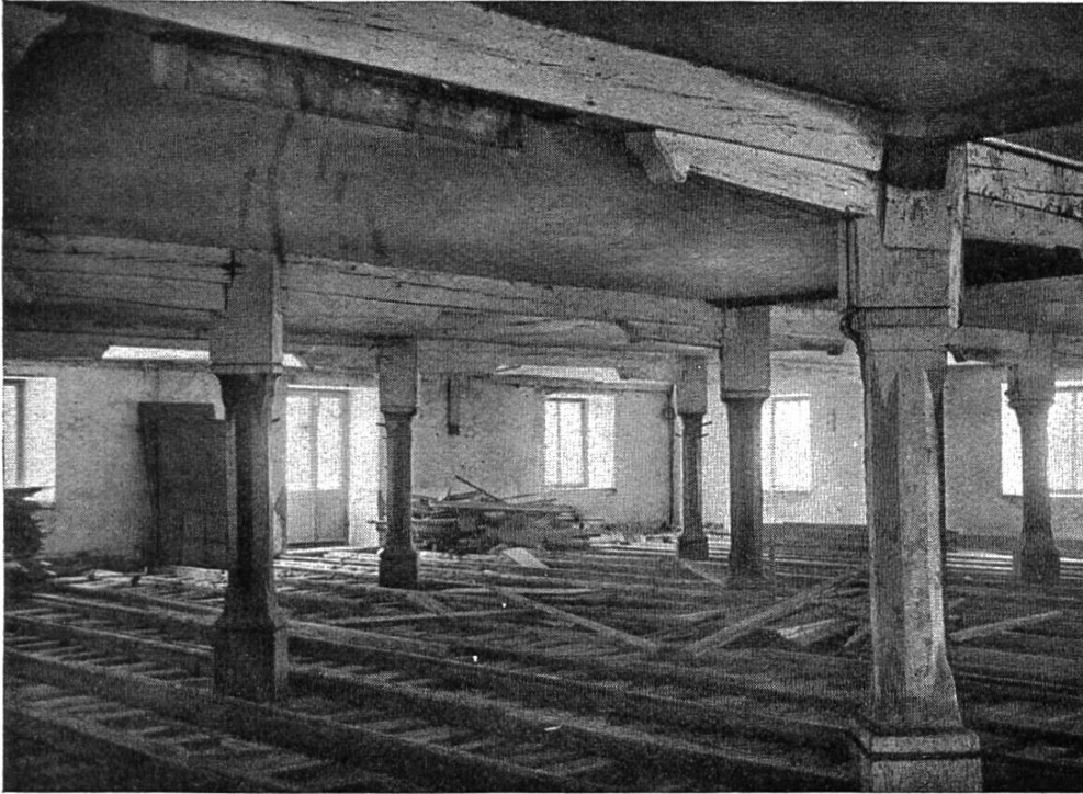
Abb. 1. Alte Kornschütte während des Umbaus.
