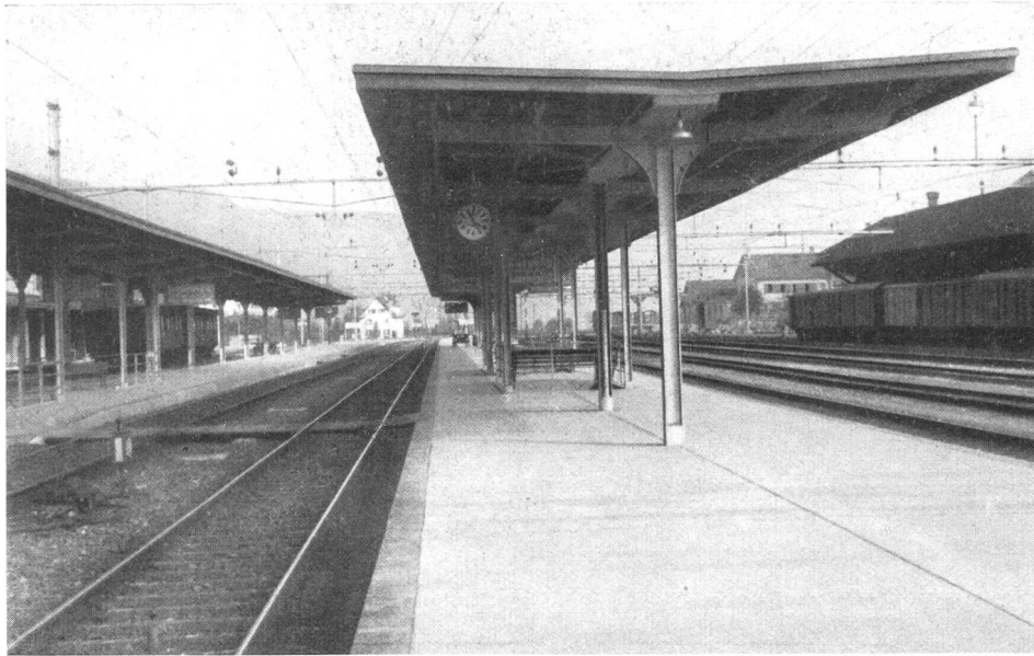
Die neue Bahnhofsanlage in Brugg Eröffnet am 1. August 1934
