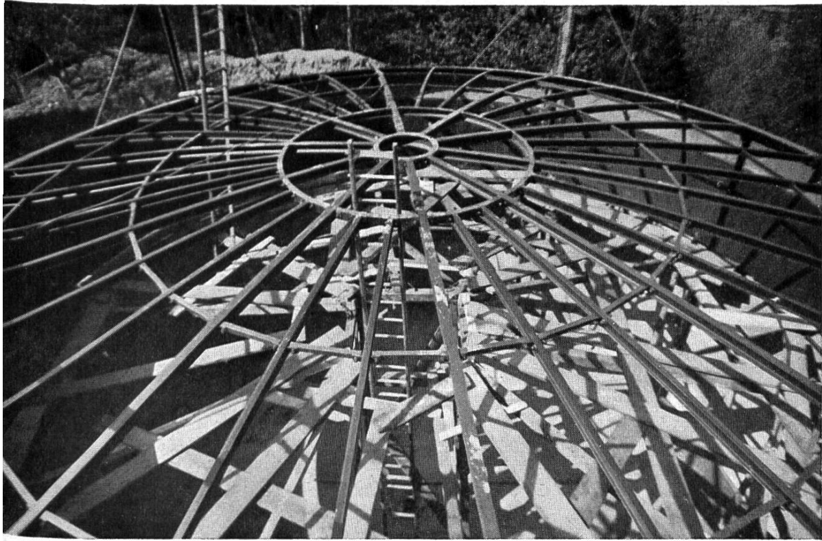
Stahlstelett eines Gasbehälters
