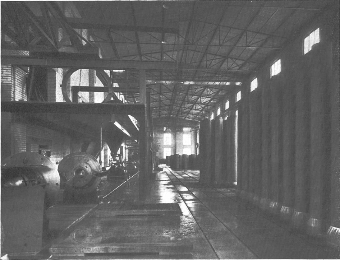
Bild 6 – Teilansicht der Superbeton-Schleuderröhren-Fabrik
