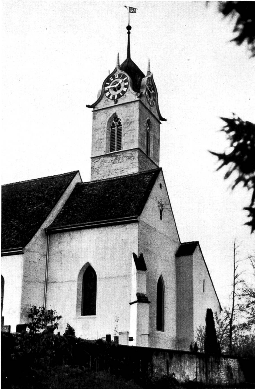
Kirche Windisch. Nach der Renovation 1949.
