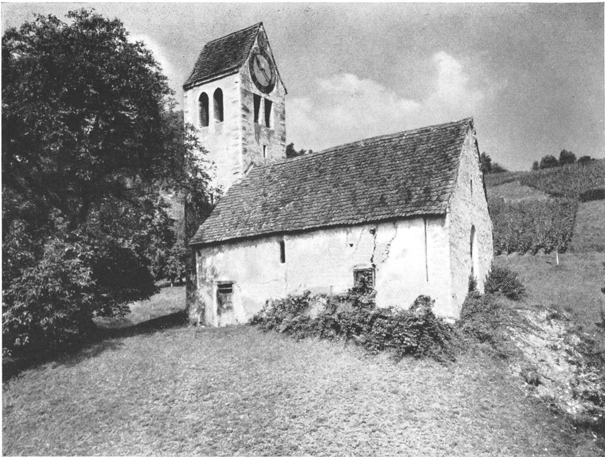
Abb. 2. Remigen. Kirche. Ansicht von Südosten
