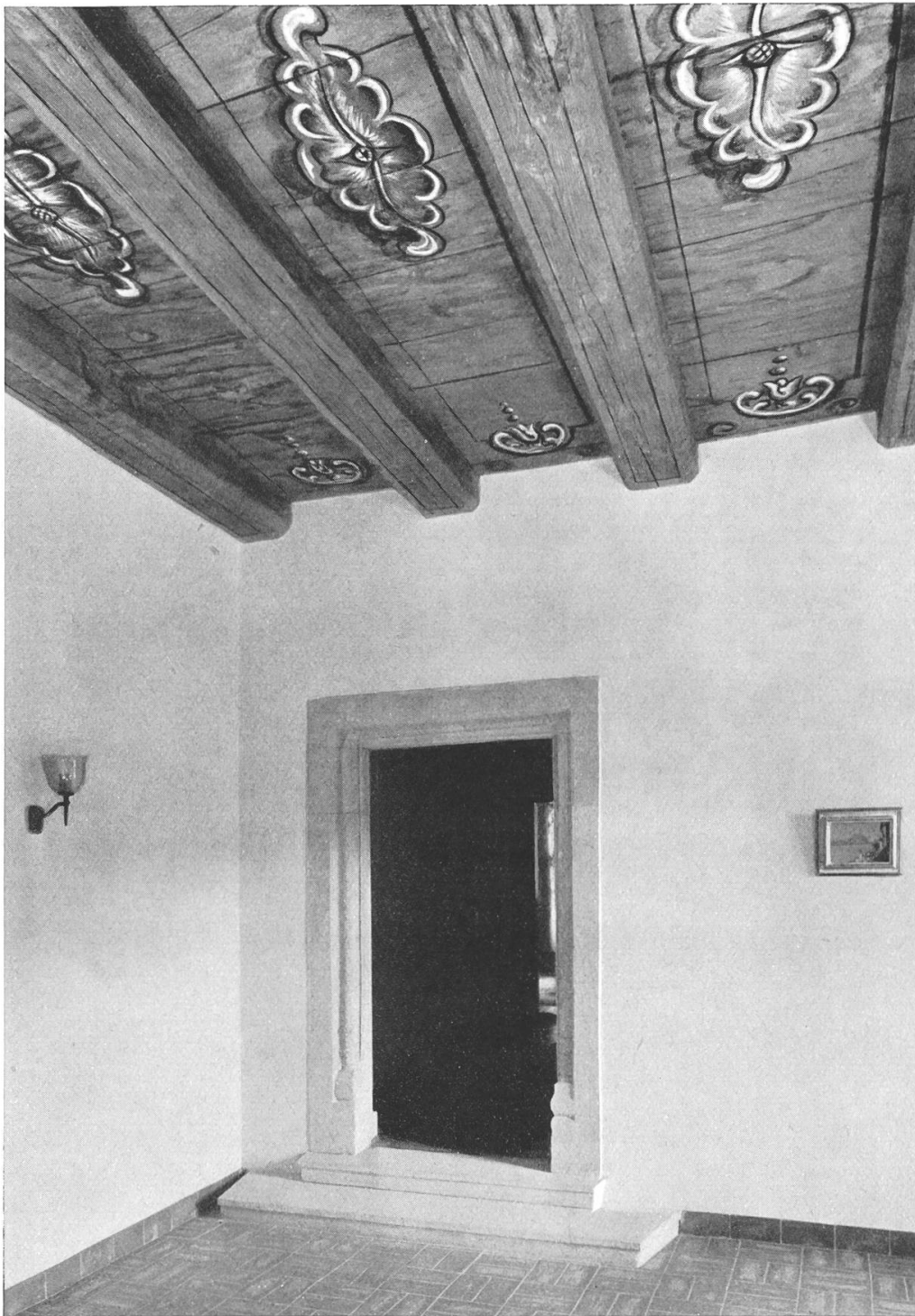
Brugg. Rathaus, Vorraum im zweiten Geschoß Barocke, bemalte Balkendecke und spätgotische Tür
