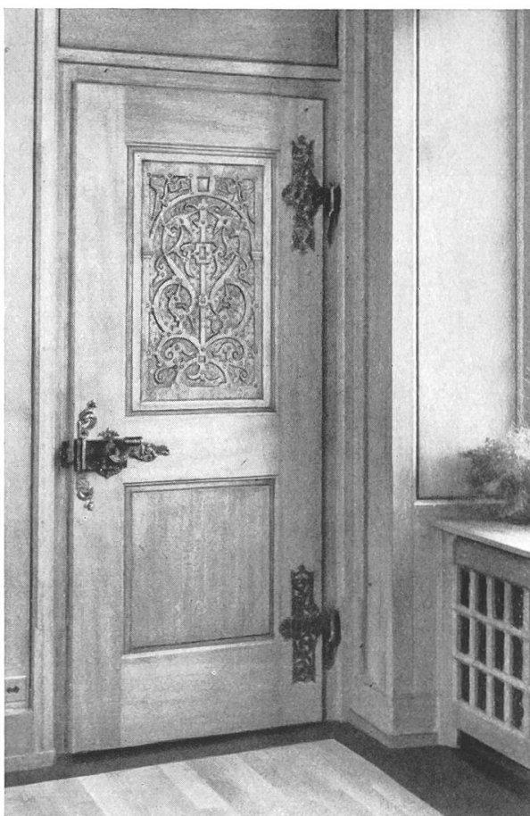
Brugg. Rathaus, hintere Ratsstube im ersten Stock. Türe mit alter Füllung
