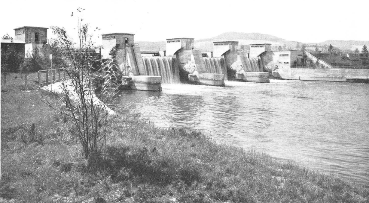
Kraftwerk Wildegg-Brugg. – Stauwehr vom Unterwasser aus 4. September 1953
