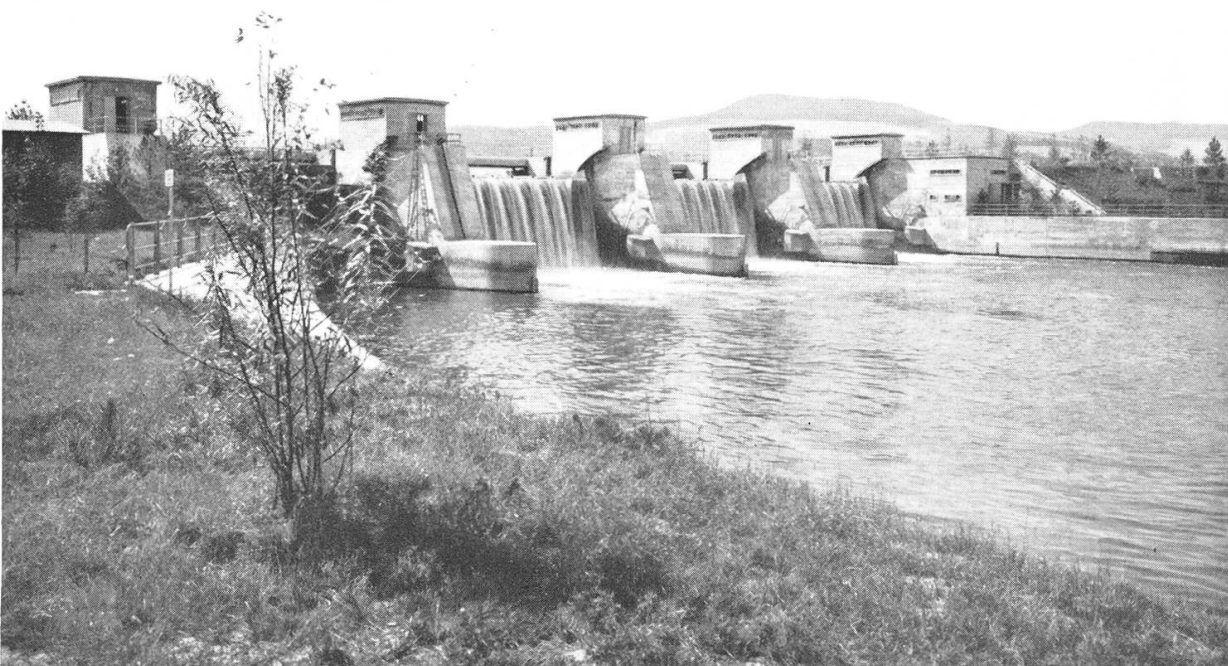
Kraftwerk Wildegg-Brugg. – Stauwehr vom Unterwasser aus 4. September 1953
