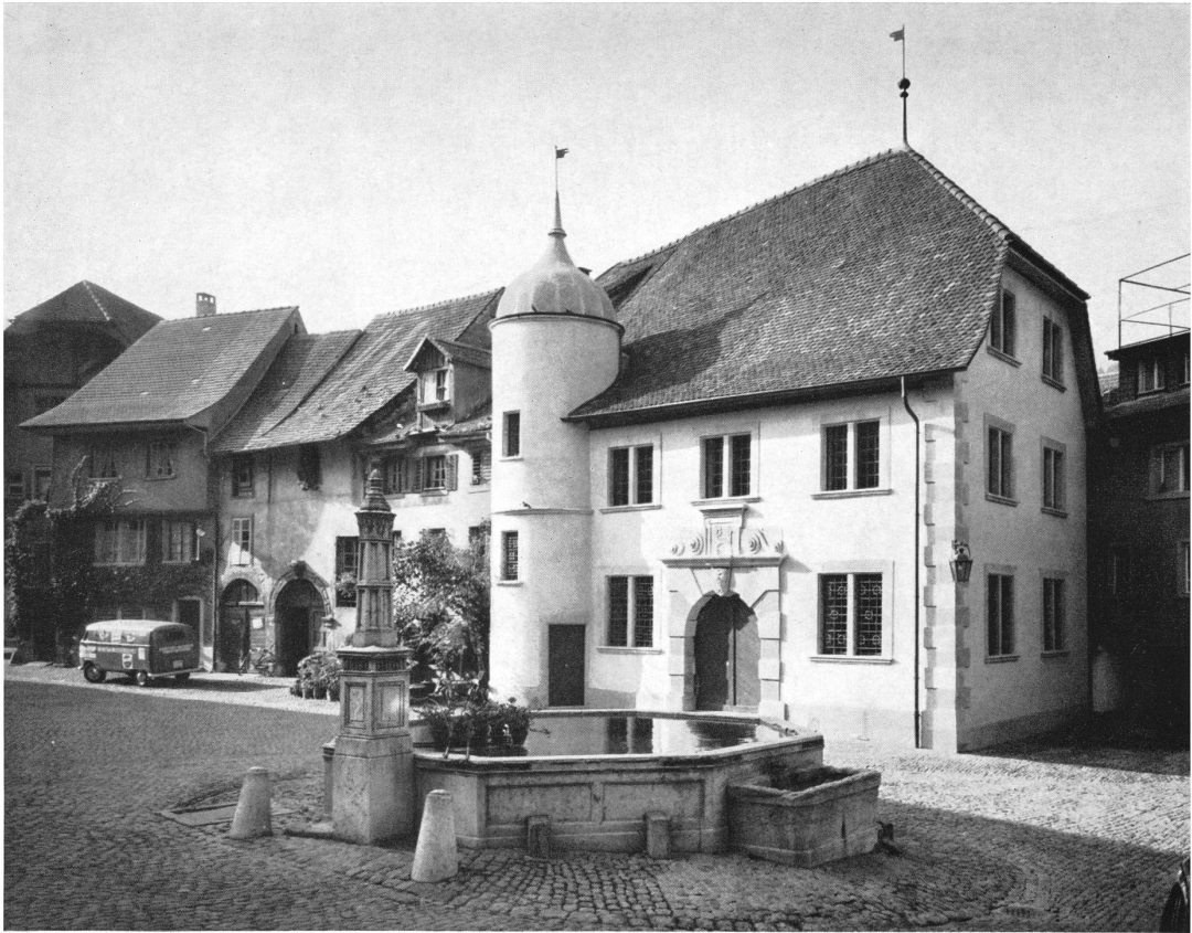
Brugg. — Zeughaus (Heimatmuseum) nach der Restauration
