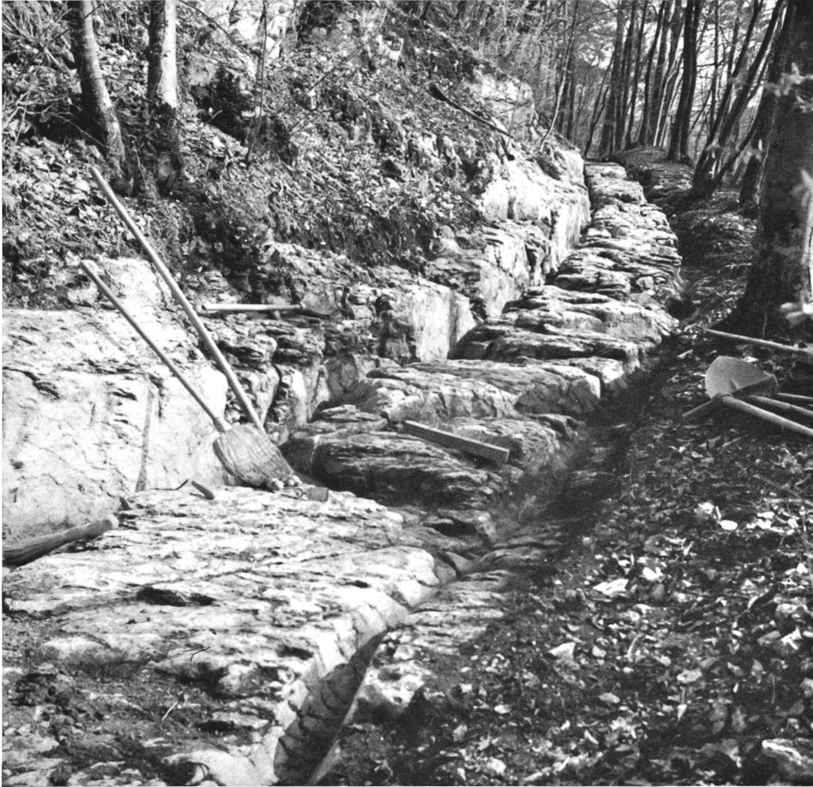
Abb. 1. Effingen, Windischtal, AG. Karrenweg, «Römerstrasse», im Fels mit Wagengeleisen. Ausgrabung 1968. (Vgl. Abb. 2, Strasse 2, A.) Photo Laur.
