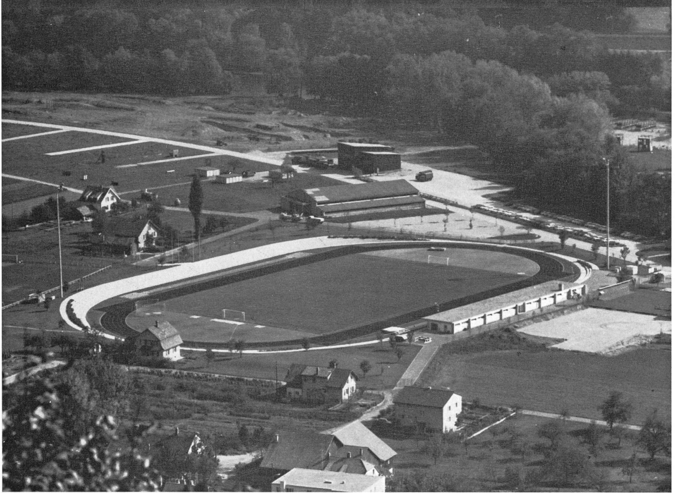
Brugg. – Sportanlage in der Au
