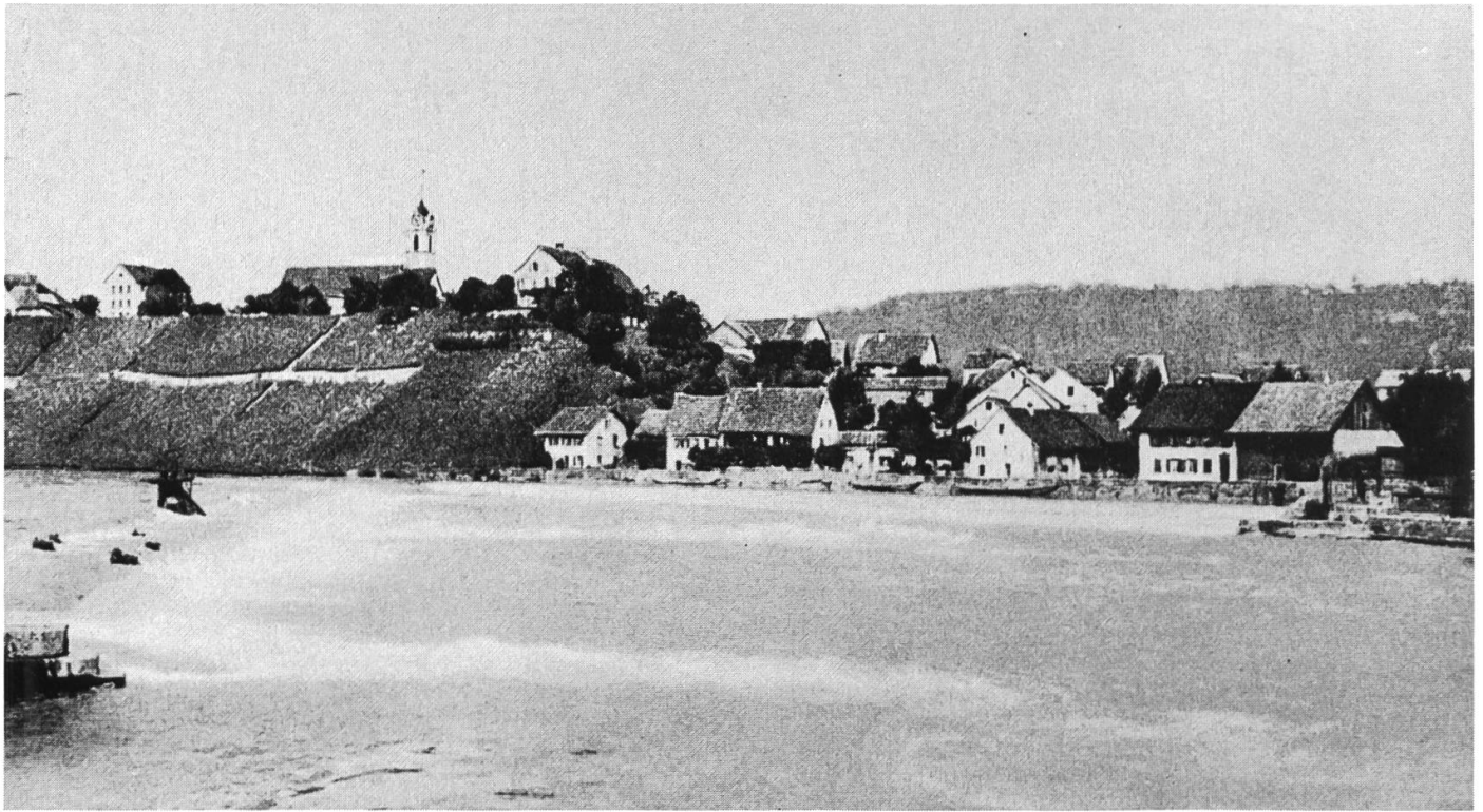
So sah die Reusswehranlage vor dem Höherstau von 1915 aus. Auf dem Bild sind mehrere Weidlinge sichtbar, die unter- und oberhalb der Windischer Lände (Ländestrasse!) festgebunden sind.
