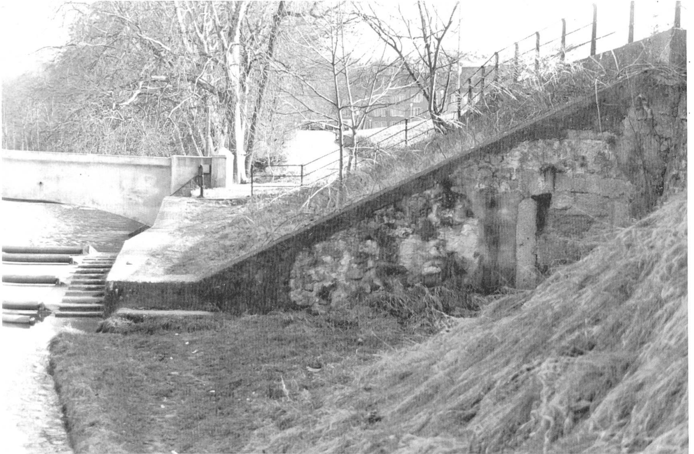
Eine der beiden übriggebliebenen Mauern des Untergeschosses der ehemaligen Mühle an der Stelle, wo die Kahnrampe beginnt. Deutlich sichtbar ist noch ein Tür-Gewänd.
