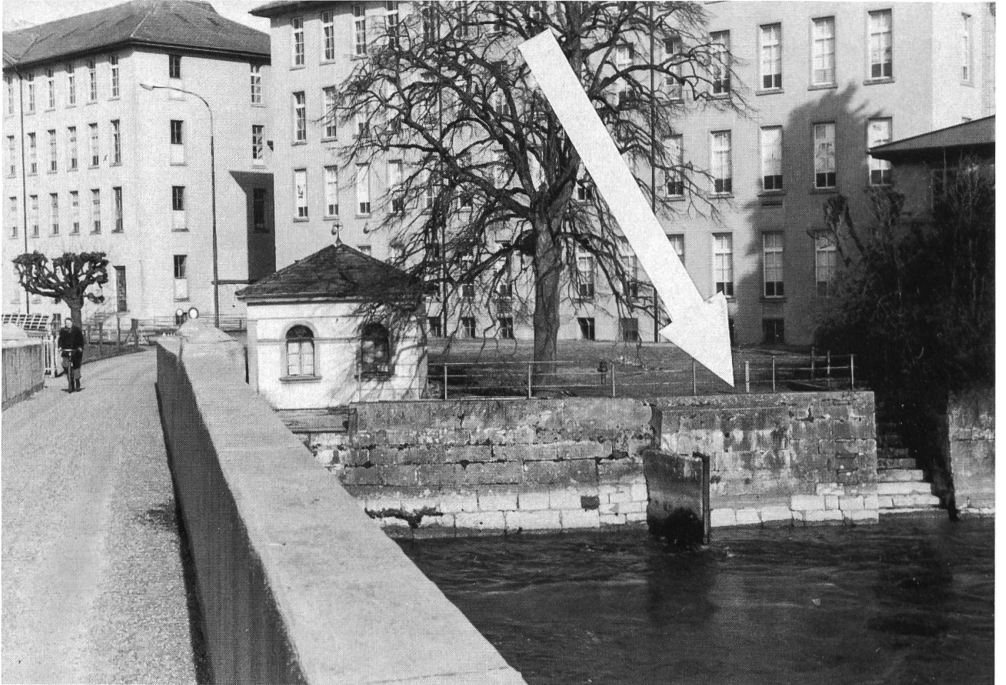
Das Widerlager des Holzstegs liegt unterhalb der heutigen Brücke.
