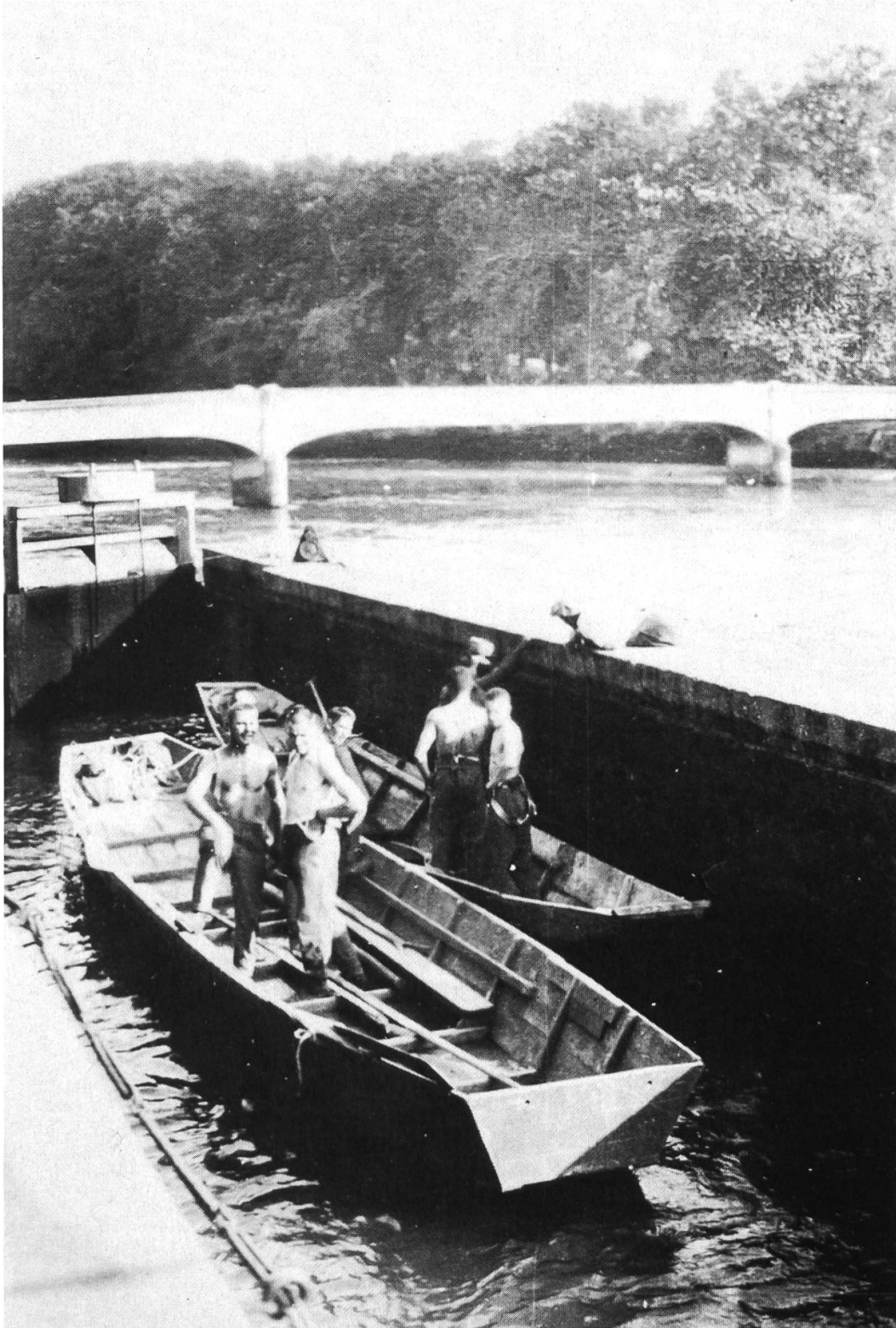
Die Kammer Schleuse nach den Revisionsarbeiten von 1919. Die im Text erwähnten Ketten sind heute noch vorhanden.
