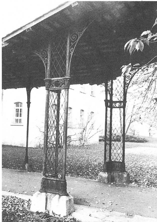
Abb. 18: Gusseisenkonstruktion in der Psychiatrischen Klinik Königsfelden.
