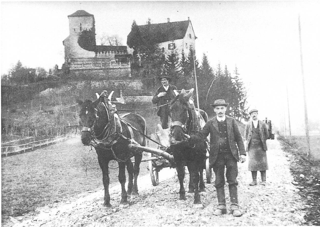
Abb. 11: Am Vorabend eines mobileren Zeitalters: Kurz vor dem Ausbruch des Ersten Weltkrieges wurde die neue Wildeggerstrasse unter dem Schloss Wildenstein gebaut.
