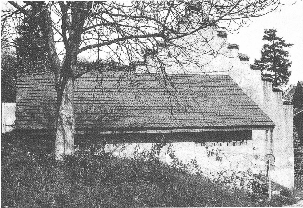
Abb. 8: Vom einstigen Kaplaneihaus «an der Steig» ist die südliche Brandmauer mit Treppengiebel erhalten geblieben, während Haus und Schopfanbau (im Vordergrund) zahlreiche Veränderungen erfuhr.
