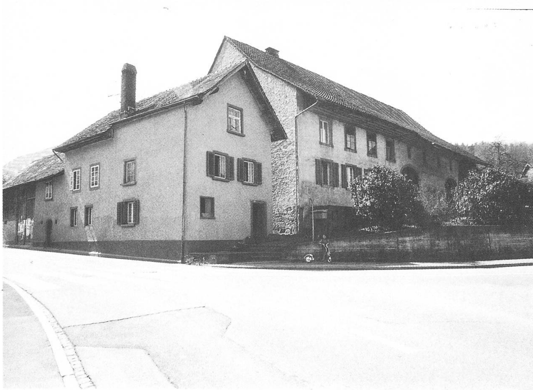
Abb. 7: Baugrund im alten Dorfraum war für die ärmeren Bewohner seit Jahrhunderten ein knappes Gut.
