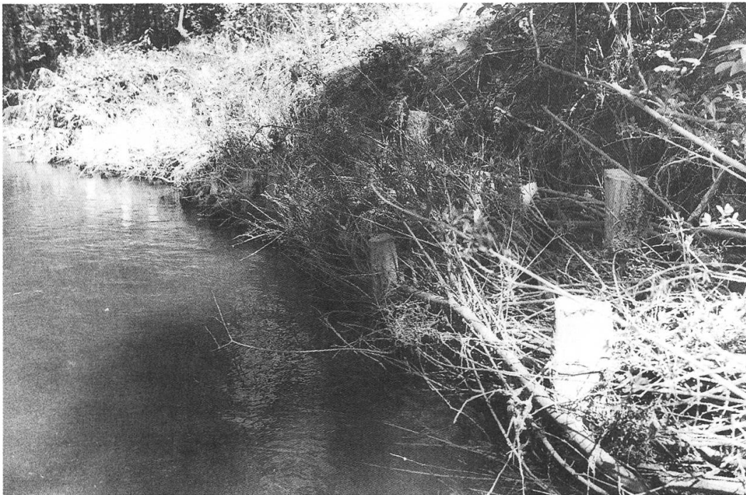
Abb. 8: Astpackungen an der unterspülten Böschung. Astpackungen aus lebenden Weiden und anderem Astwerk werden verpflockt, mit Spanndrähten verdichtet und befestigt. Die Äste fördern die Ablagerung von Sand und Schluff durch eine Verminderung der Fliessgeschwindigkeit. Die eingelegten Weiden treiben aus, wobei ihr Wurzelwerk das Ufer vor weiterer Erosion schützt.
