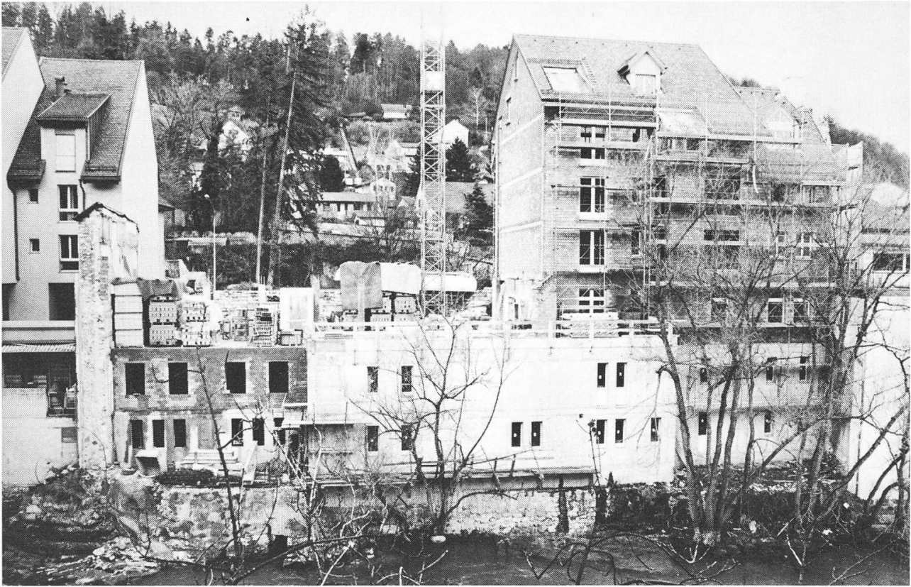
Februar 1988 – Zwischen Restaurant Aarhof und der Zollplätzliüberbauung entsteht das Wohn- und Geschäftshaus der Firma Otto Kern AG.
