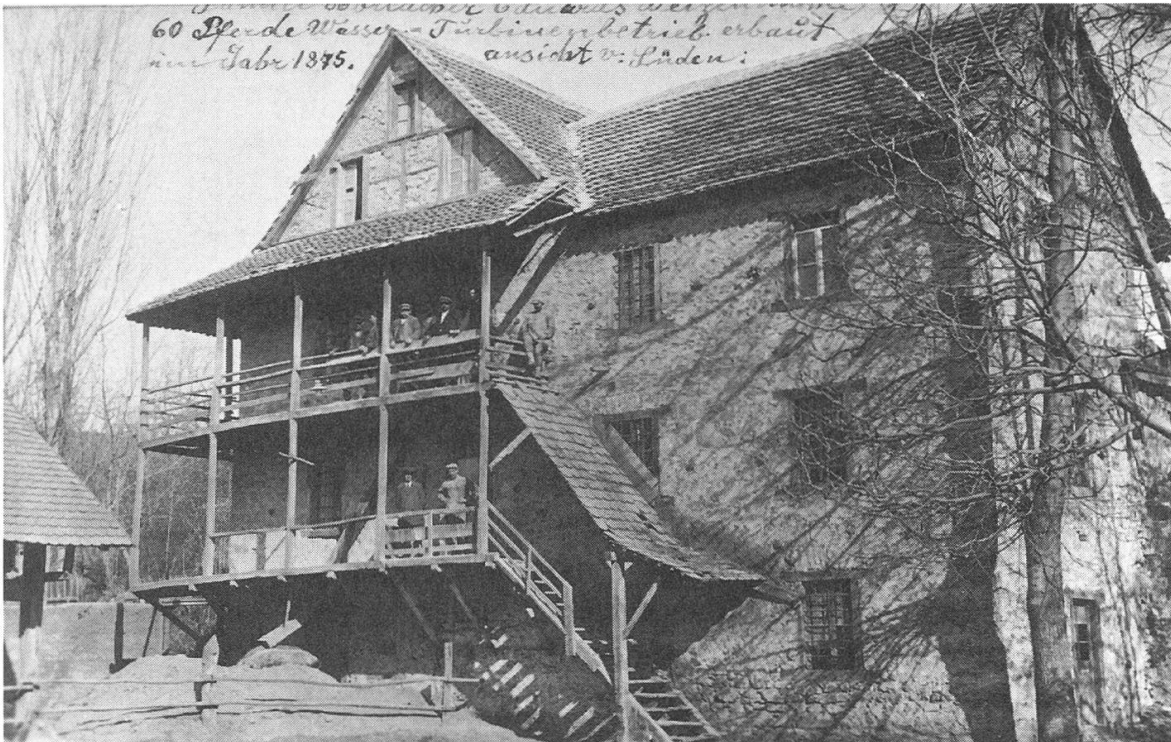
Die neue, ab 1875 erbaute Mühle. Die Entwicklung und der unternehmerische Geist der Familie Horlacher lassen sich kaum augenfälliger illustrieren.
