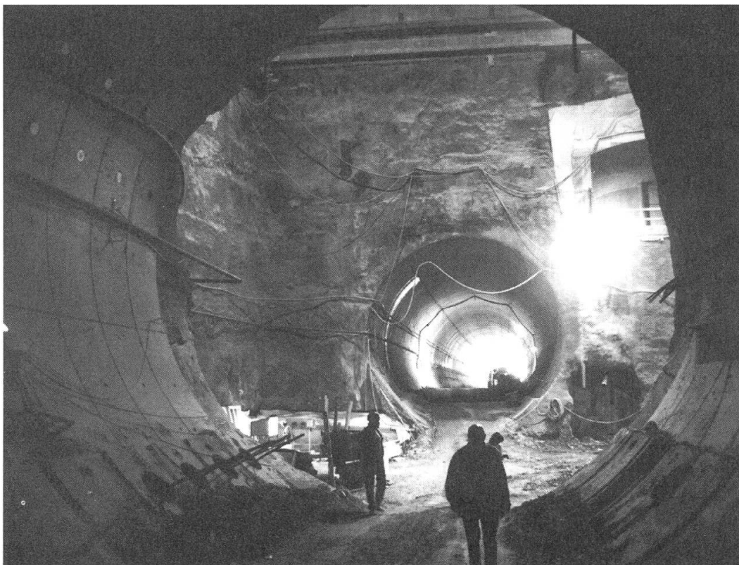
JUNI 1992 – Aggressive Tiefenwässer bewirken beim Bau des Bözbergtunnels eine Bauverzögerung von einem halben Jahr. Im Bild die künftige unterirdische Betriebszentrale bei Effingen.
