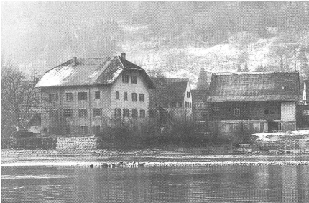
APRIL 1992 – Die kulturhistorisch bedeutungsvolle Gipsmühle in Lauffohr wird umgebaut. Der nördlich gelegene Mühleschopf wurde von den Kanuten in einen Bootschopf mit Klubhaus umgebaut. Foto: Jörg Wägli, Brugger Tagblatt
