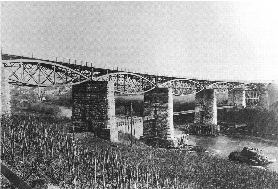
Blick von der Baslerstrasse in Umiken. Baubeginn des Leergerüstes auf der Brugger Seite
