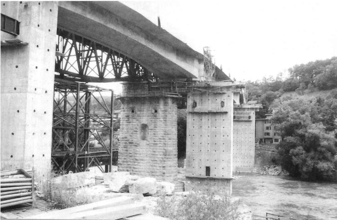
Position der neuen Brücke nach dem ersten Vershub von 7 Metern.
