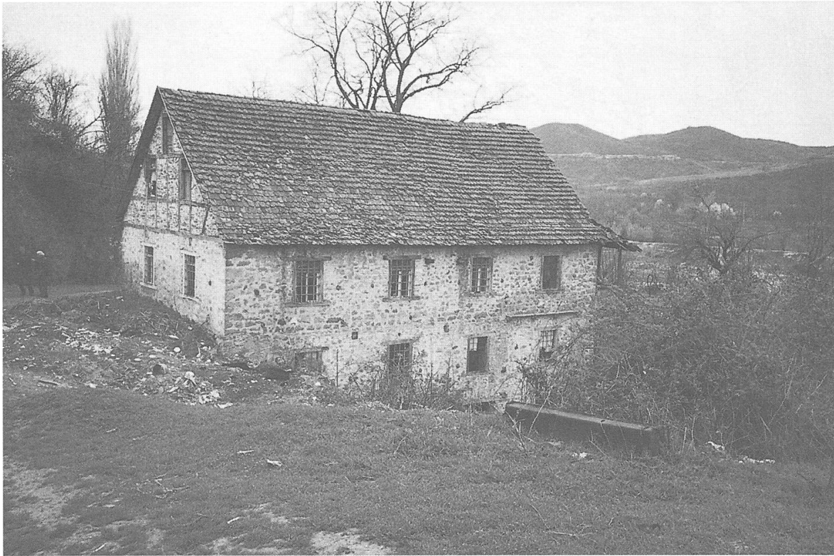
Die solide gefügten Bruchstein-Mauern der 1875/76 erbauten Mühle sind noch in ausgezeichnetem Zustand. Ansicht von Norden.
