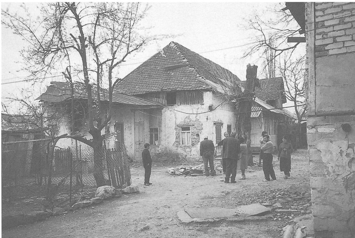
Blick auf den Innenhof des Horlacherschen Gebäude-Ensembles mit dem arg mitgenommenen zweiten, bescheideneren Wohnhaus.
