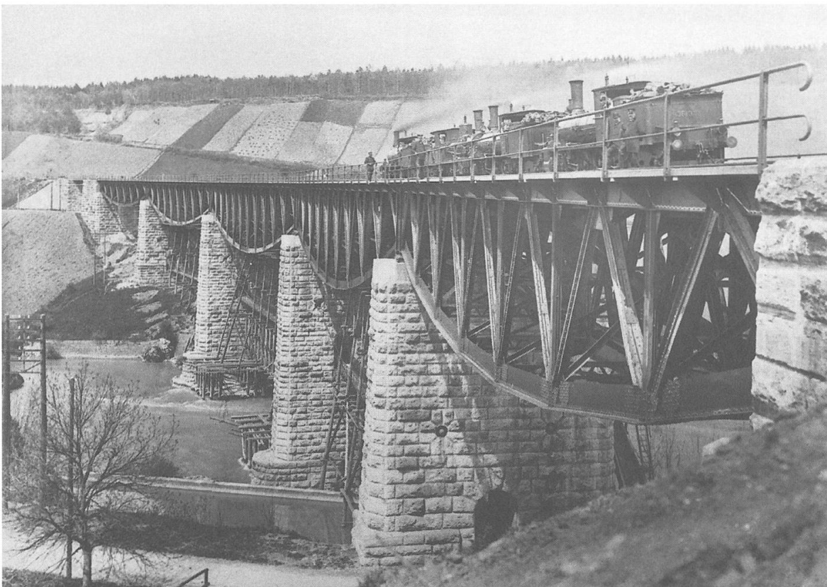
Die zweite Eisenbahnbrücke von 1905, wahrscheinlich während eines Belastungstests. Die Gerüste stehen teilweise noch.
