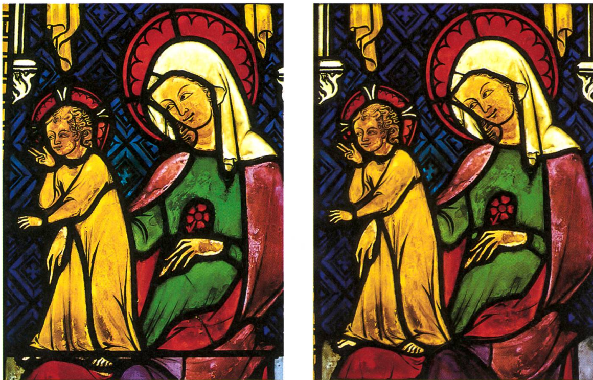
Abb. 25 Menschwerdung Christi, n II, 5c; Maria mit dem Christusknaben aus der Anbetung der Hl. Drei Könige; links mit 6 mm breitem Nüscheler- Blei, rechts nach der Neuverbleiung.
