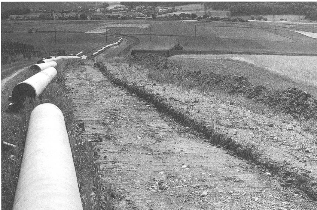
Bauarbeiten auf dem Gasleitungstrasse. Die Leitungsrohre sind bereits neben dem abhumusierten Trasse ausgelegt. Im Hintergrund Rüfenach und Hinterrein.
