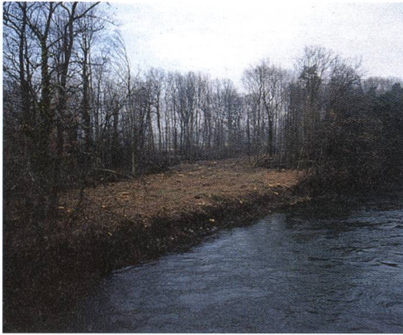
Der Einlauftrichter nach dem Ausholzen der Baufläche.
