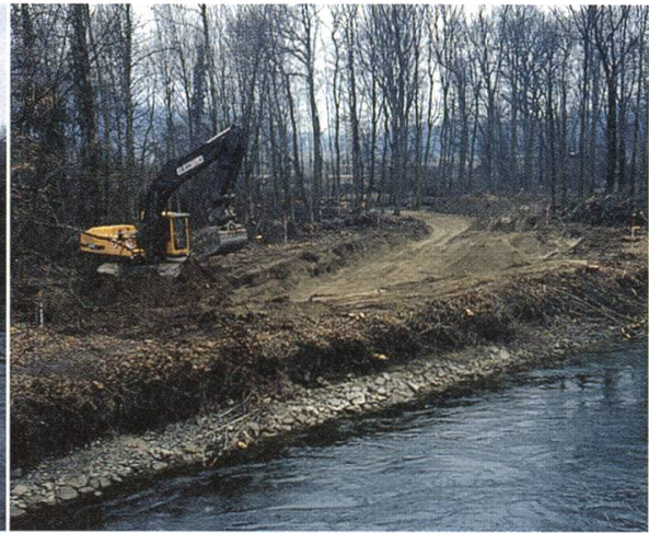
Leistungsfähige Baumaschinen sorgen für den Aushub.
