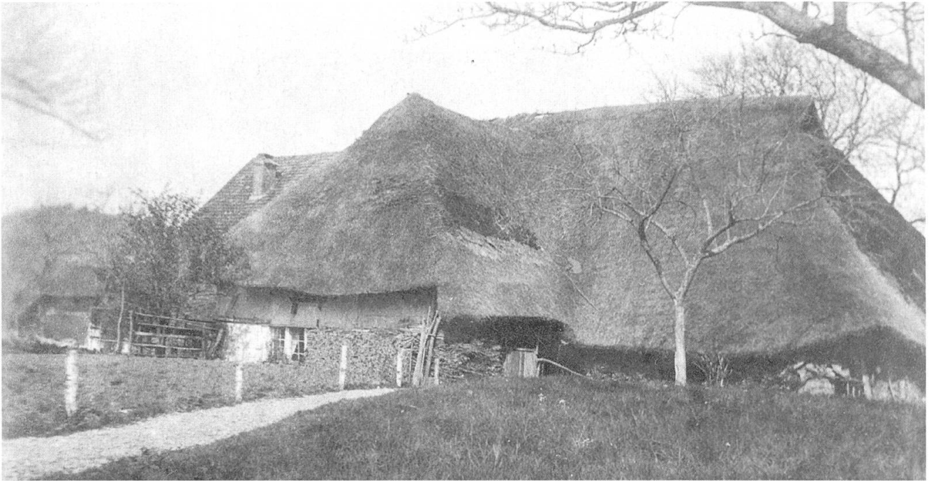
Bauernhaus in Altenburg mit Strohdach.
