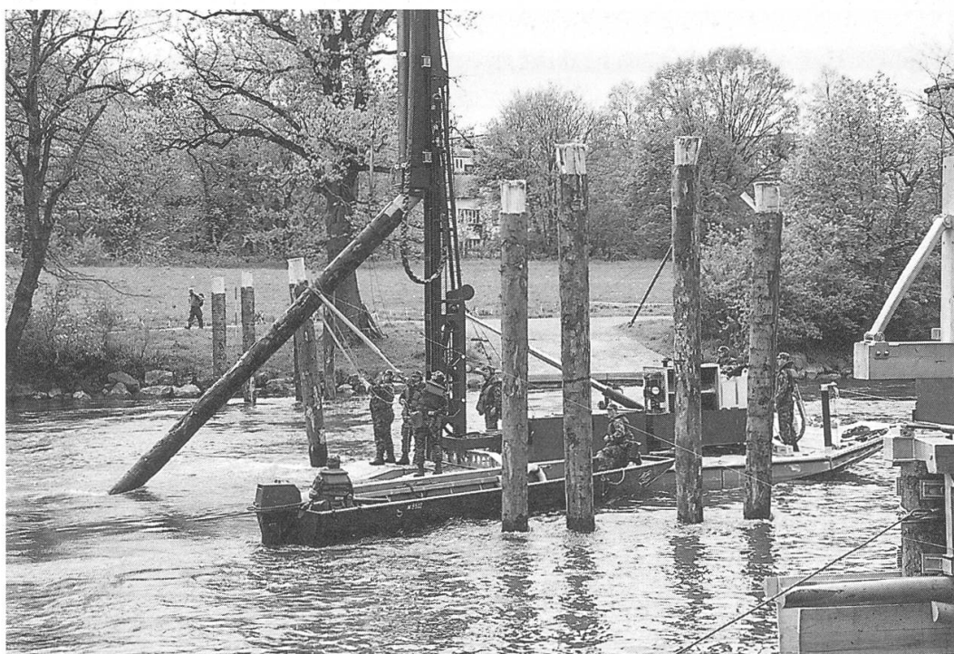
Mai 2000 – Eine Brücke für das verbindende Fest «Potz 2-tuusig» entsteht. Zu kompakter Flussgrund verursacht eine Verschiebung der Brücke.
