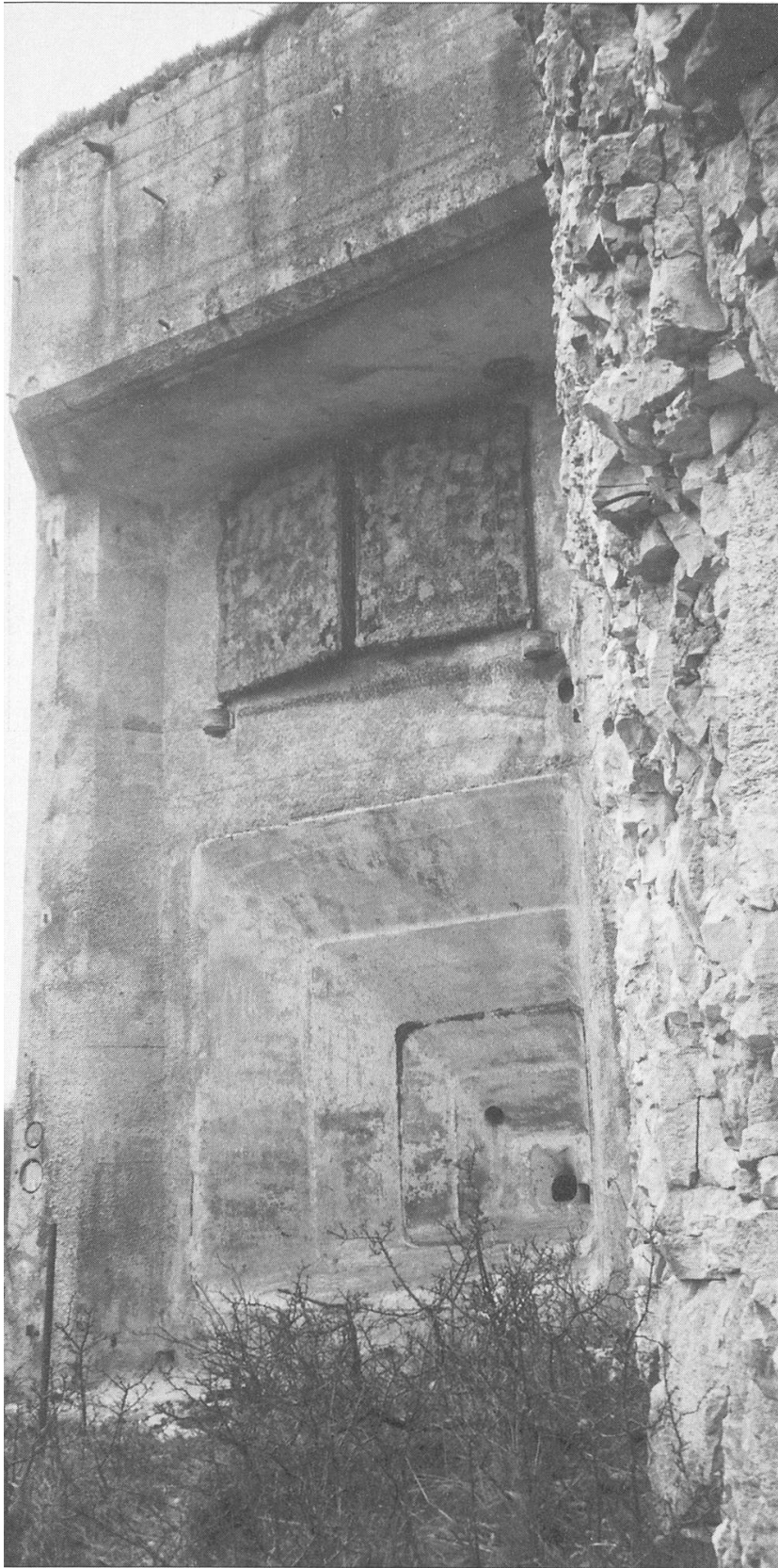
Abb. 22 Artilleriewerk Besserstein, Geschützstand West. Unten ist die Scharte mit der runden Öffnung für das Kanonenrohr, oben die geschlossene Scharte für den Beobachter. Bild von 2002.
