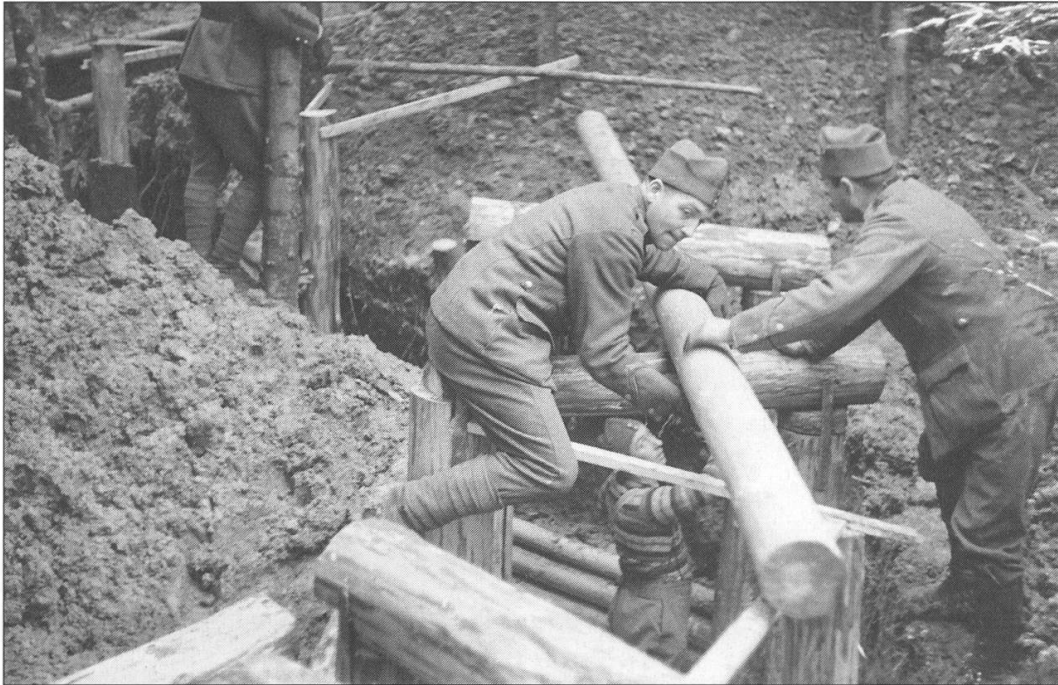
Abb. 1 Ein gewundener Verbindungsgraben wird überdeckt.
