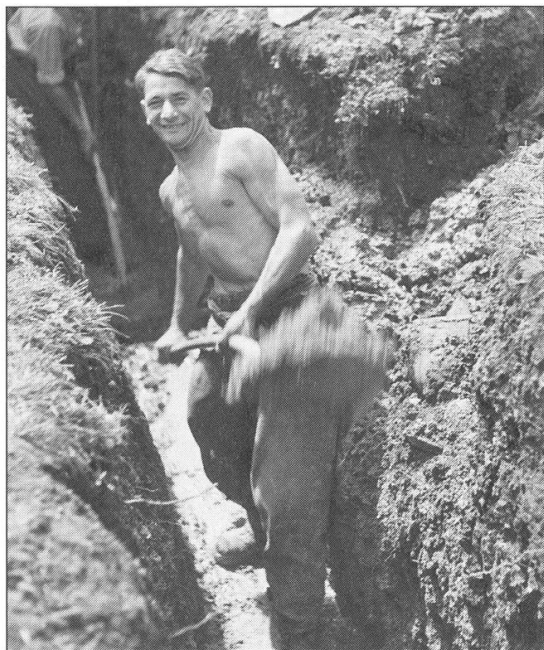
Abb. 24 einige tausend Meter Kabelgräben,
