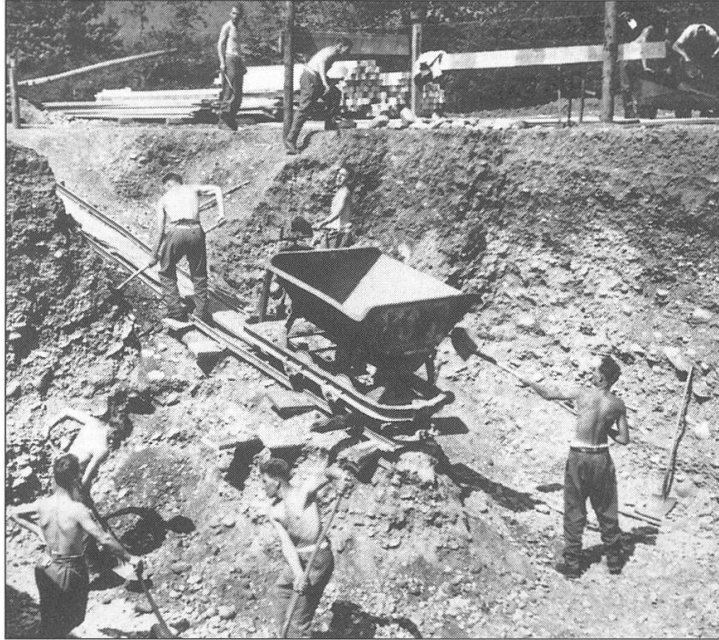
Abb. 5 Aushub im Kiesboden, etwa 200 m 3 (5000 Karretten).
