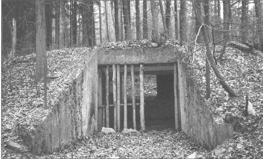
Abb. 17 Rückseite mit Einfahrt, berechnet für Kanone 10,5 cm.
