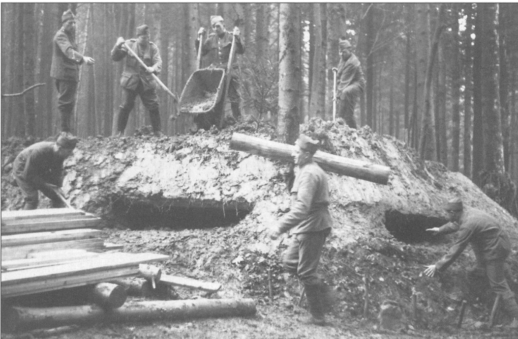
Abb. 4 Überdecken des Holzbunkers für zwei Infanteriewaffen.
