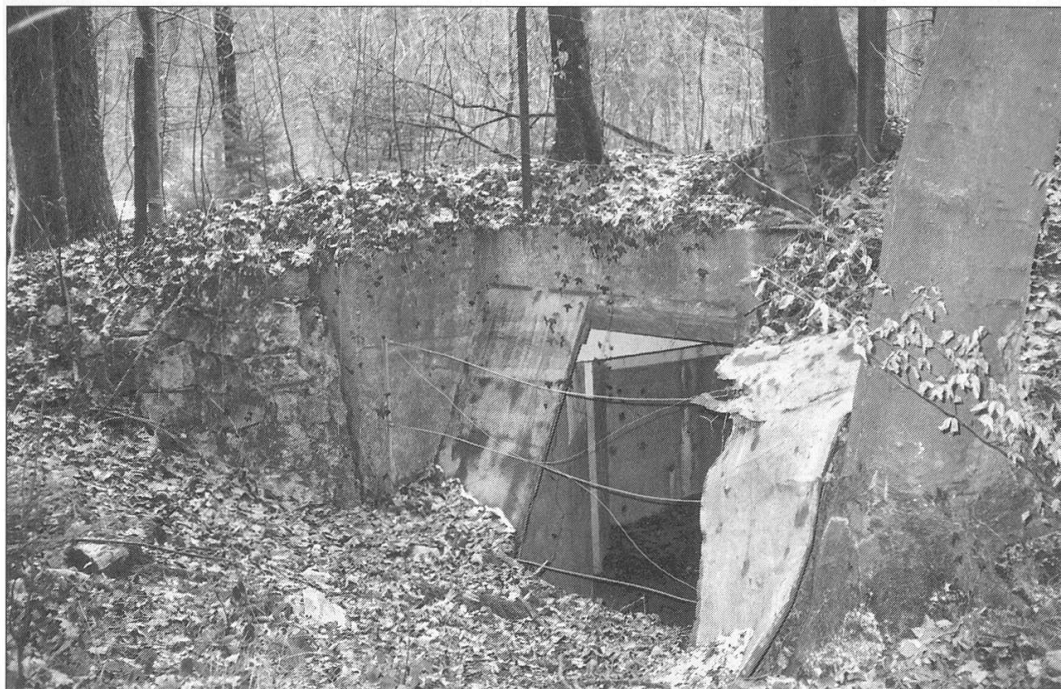
Abb. 18 Frontseite mit grosser Scharte für das Geschützrohr.
