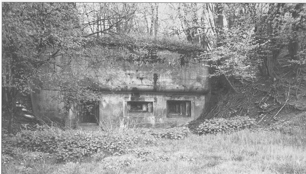
Abb. 16 Ik/Mg Bunker: Scharte links für die Ik, rechts für das Mg, in der Mitte für den Beobachter (Nr. 32 auf der Karte 30). Bilder von 1999.
