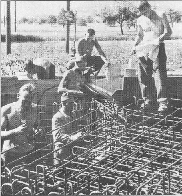
Abb. 7 Armierung der Decke, Dicke der Eisen 18 mm.
