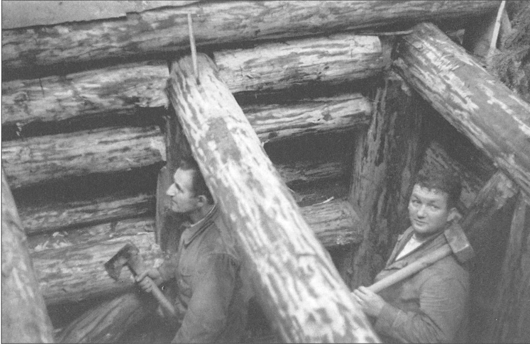
Abb. 3 Waffenstellung vor dem Einsetzen der Deckenbalken.
