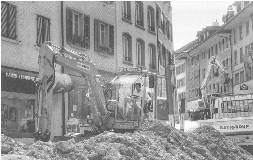
Oktober 2002 - Leitungsbauten stehen am Anfang der Umsetzung von CityPlus.
