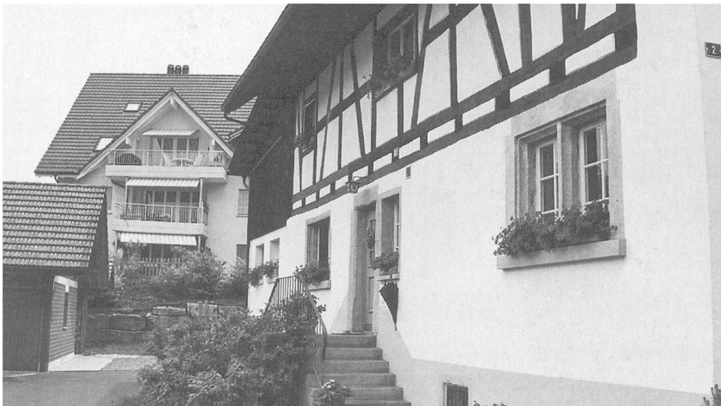
Altes und neues Mülligen. Riegelhaus am Mülirain, mit der angrenzenden Neuüberbauung Rösslimatt.
