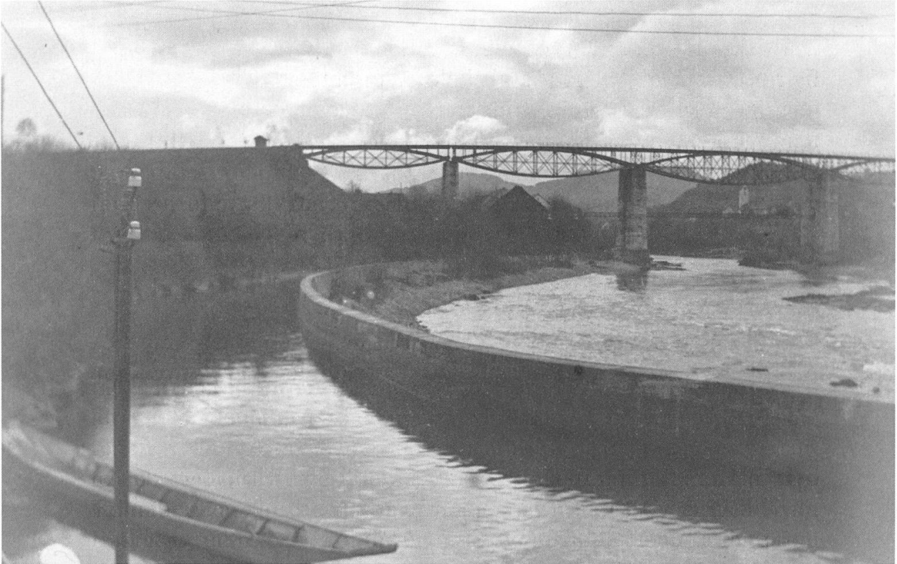
Die Altenburger Eisenbahnbrücke mit Oberwasserkanal.
