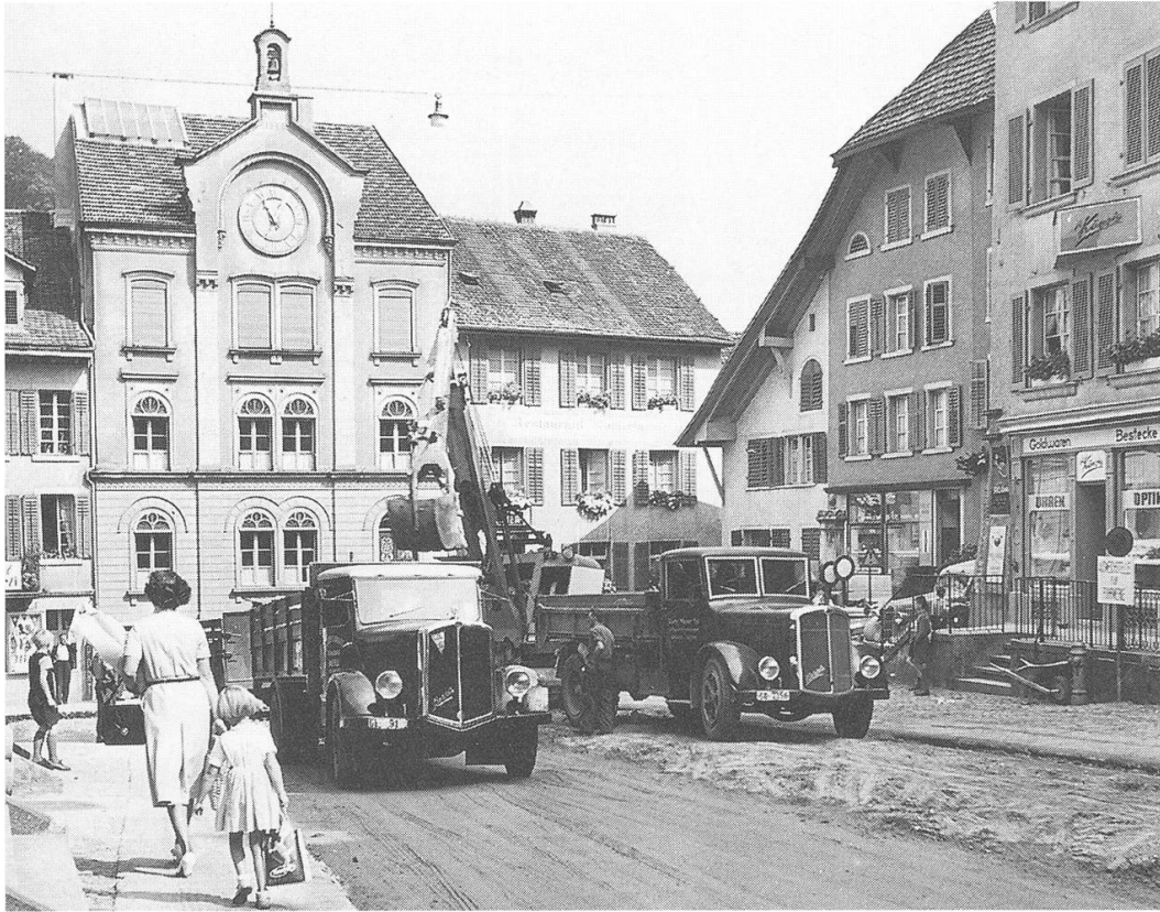
1950/51: Priorität für den zunehmenden Verkehr: Die Hauptstrasse, bisher mit Pflastersteinen ausgelegt, erhält eine breite Asphaltfahrbahn.
