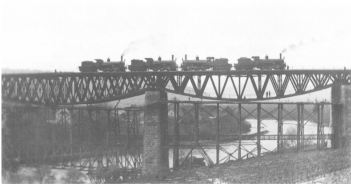
Die Belastungsprobe für die neue Eisenbahnbrücke gelingt. (vgl. «Brugger Neujaarsblätter» 106 (1996) 111–132)
