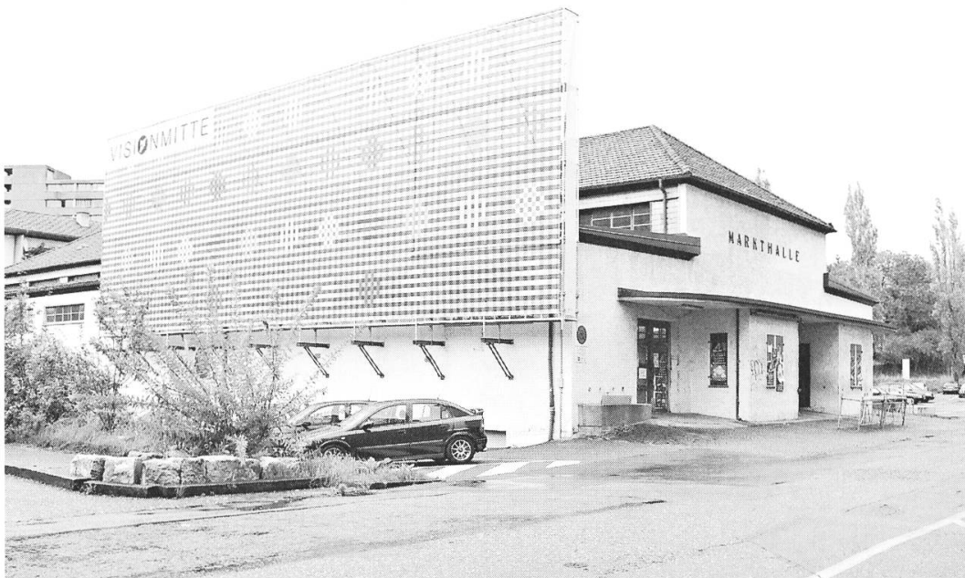
August 2004 – Wie lange steht die Markthalle noch im Planungsparameter der «Vision Mitte»?
