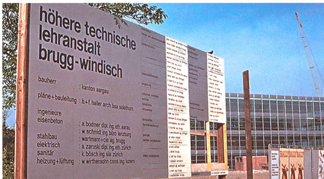
Professor Fritz Haller entwarf das Gebäude für die HTL: ein ambitioniertes Vorhaben.
