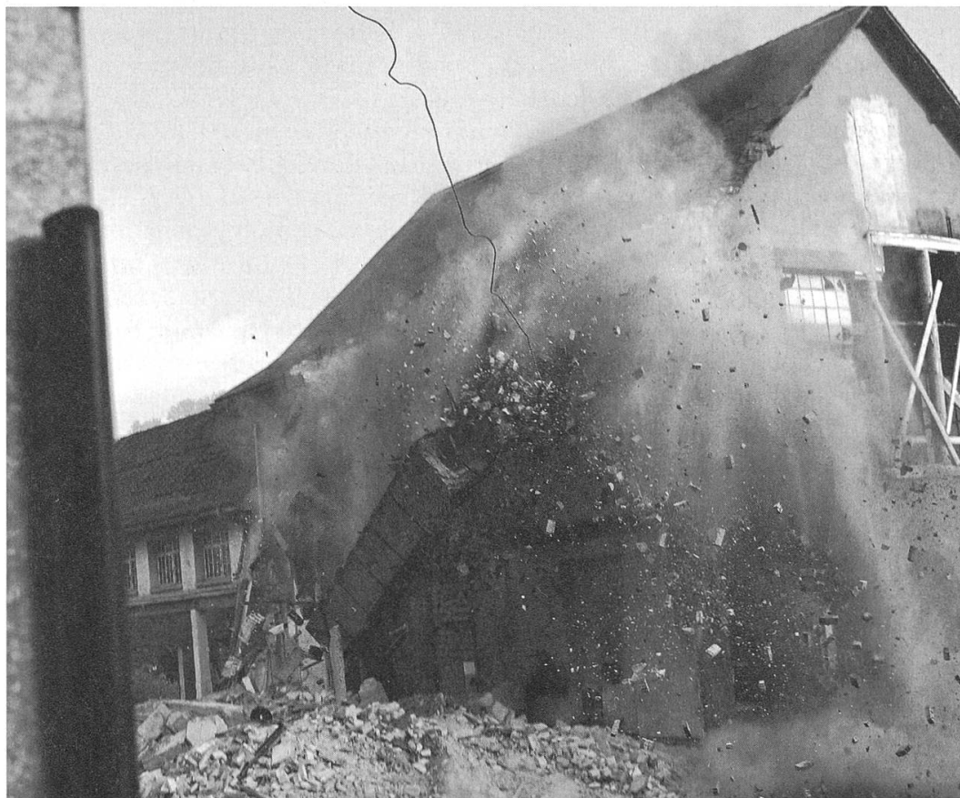
September 2005 – Im Verlauf des Jahres wird das alte Gaswerk abgebrochen. Der 1950 erstellte Kohlenbunker wird im Januar rezykliert und der Kamin im September gesprengt. Fotos: Louis Probst, «Aargauer Zeitung»
