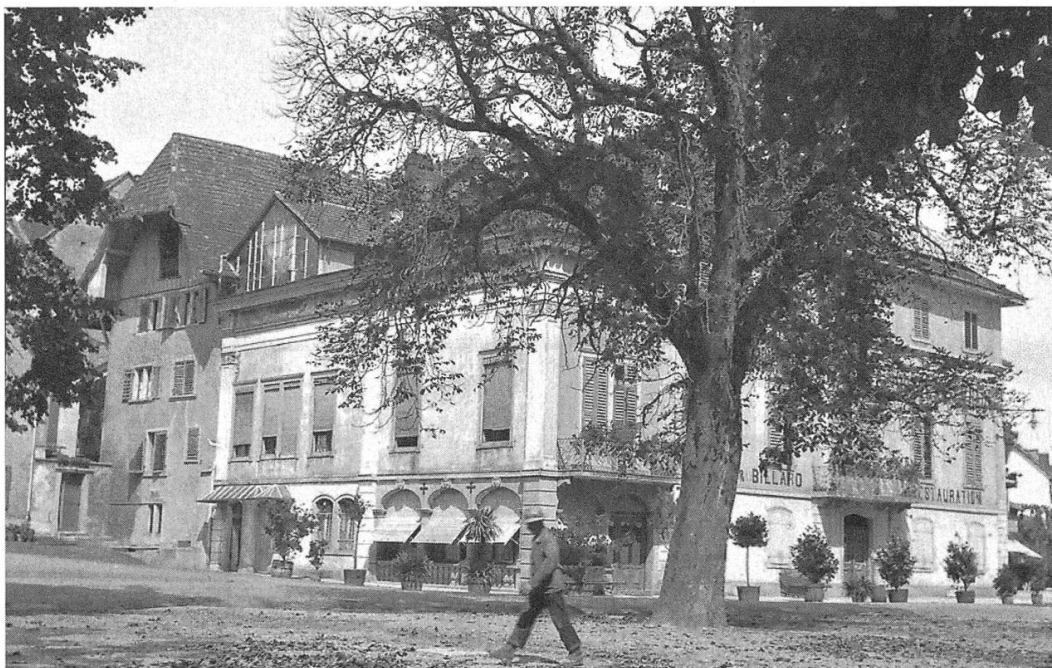
Das Rote Haus zu Brugg mit dem 1906 genehmigten Anbau.
