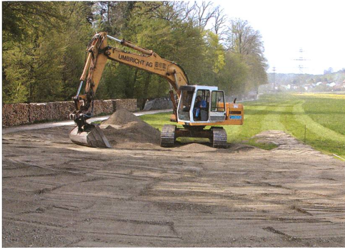
Deponie in Riniken: Schutz der Ackerfläche durch Kiesschicht
