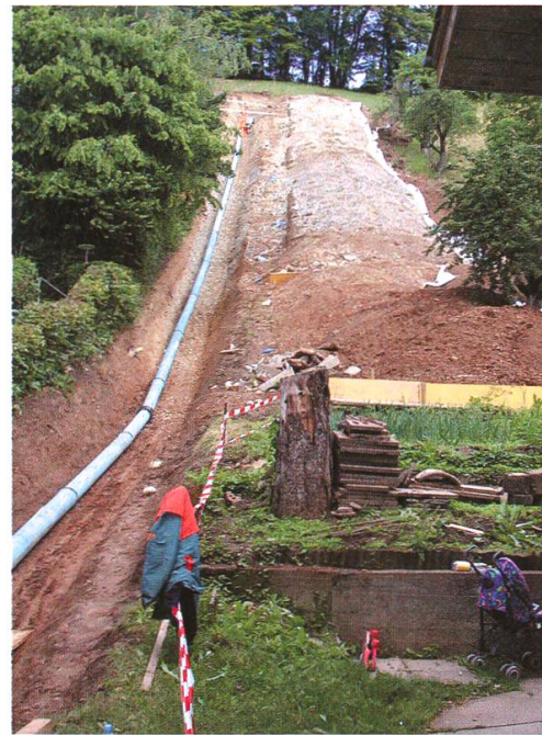
Die neue Wasserzu- und -ableitung
