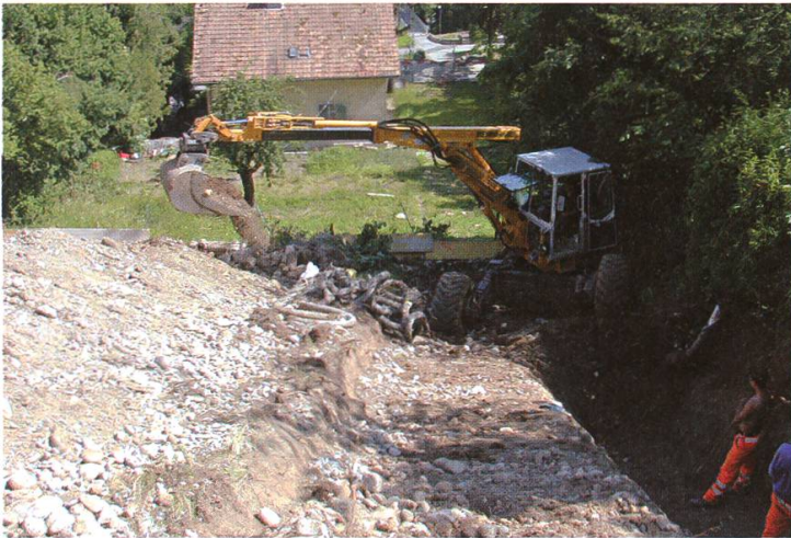
Grabenbau im Steilgelände oberhalb der Brunnenmühle
