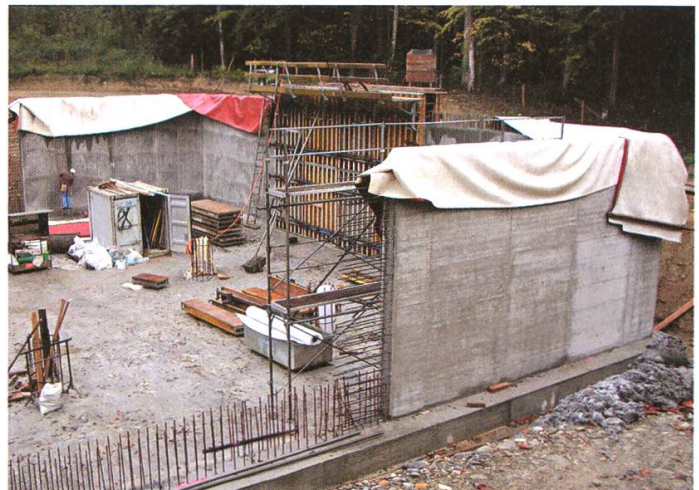
Betonieren der Wände des neuen Reservoirs
