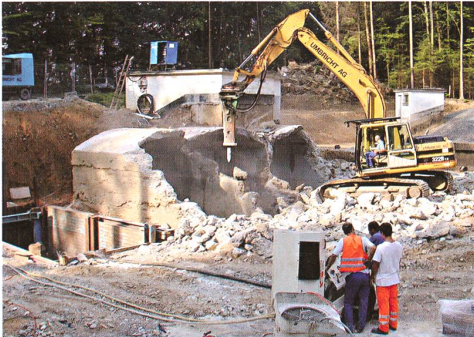
Abbruch der Reservoirkammern aus dem Jahr 1898
