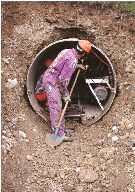
Pressvortrieb der Leitungen im unmittelbaren Bereich des neuen Reservoirs
