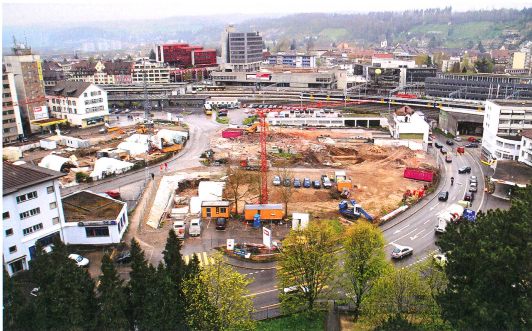
April 2008 – Das Areal der VISION MITTE wird vorbereitet, die alten Gebäude sind abgebrochen und der Untergrund wird archäologisch untersucht.
