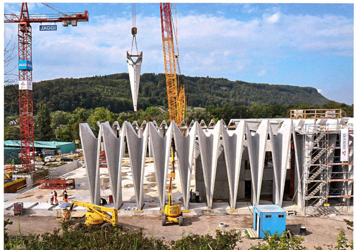
Der 500-Tonnen-Raupenkran platziert Betonelemente bis zu 50 Tonnen
