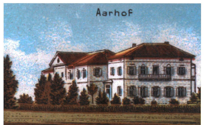
Ehemaliges Aarhof-Gebäude (Teil einer Postkarte «Gruss aus Villnachern»)
