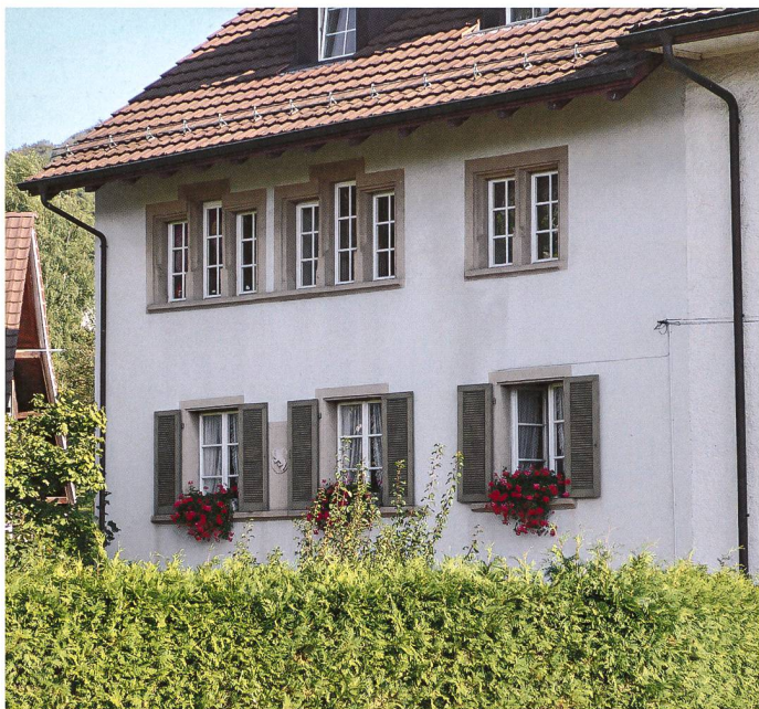
Haus Nr. 80 A, in der Vorstadt (ehemalige «Untervogtei»)
