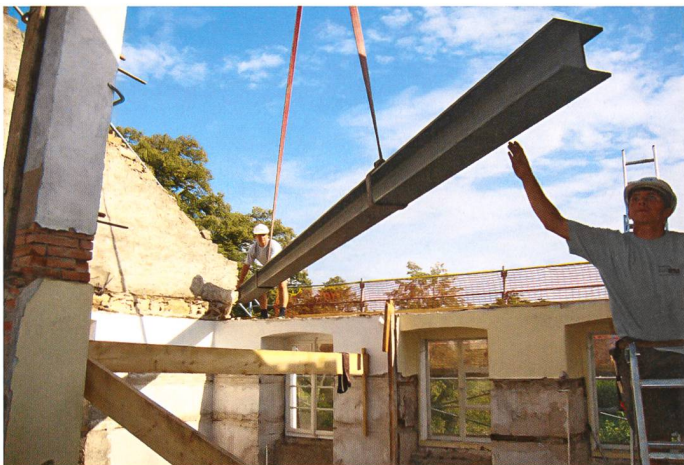
Einziehen der Stahlträger im ehemaligen Ökonomierteil
