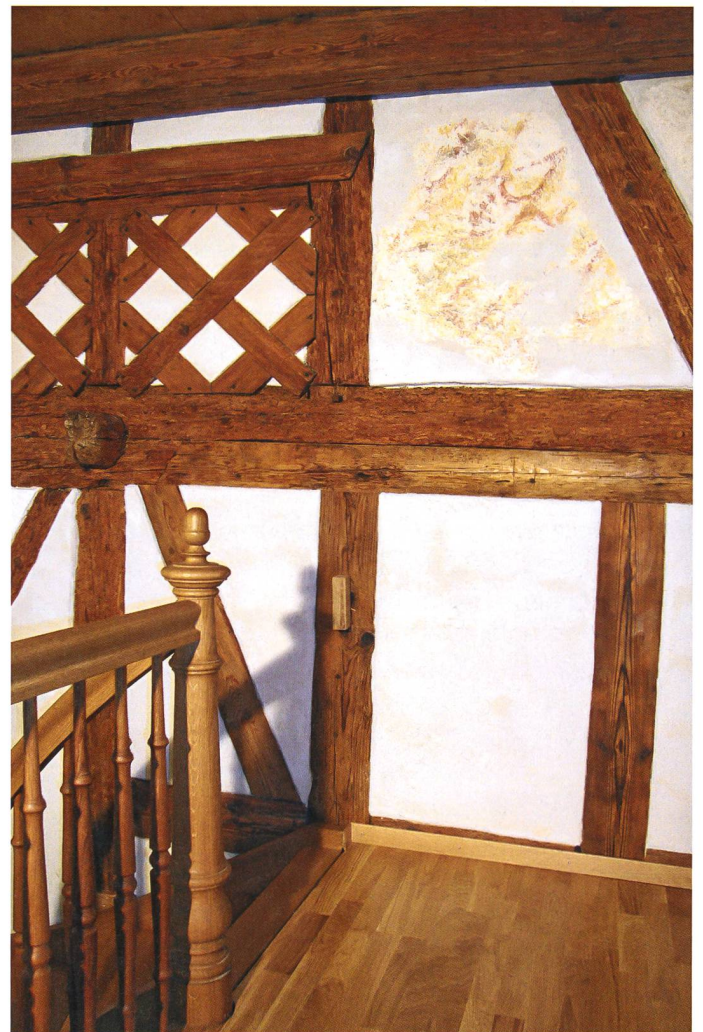
Die einstige reussabwärts gelegene, bemalte Aussenfassade des Kernbaus, welche in den ausgebauten Ökonomierteil integriert wurde
