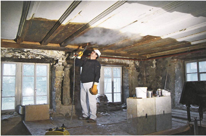
Gotischer Raum von 1570. Freilegen der Farbschichten
