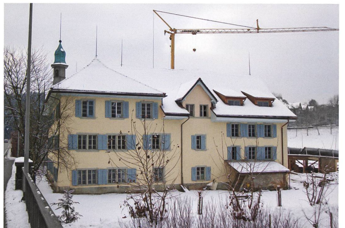
Fassade reussseitig. Der Kernbau erstreckt sich bis Ende Giebellukarne. Rechts davon das umgebaute Ökonomiegebäude mit versetztem Stockwerk wegen des über das Terrain ragenden hohen Kellerscheitels
