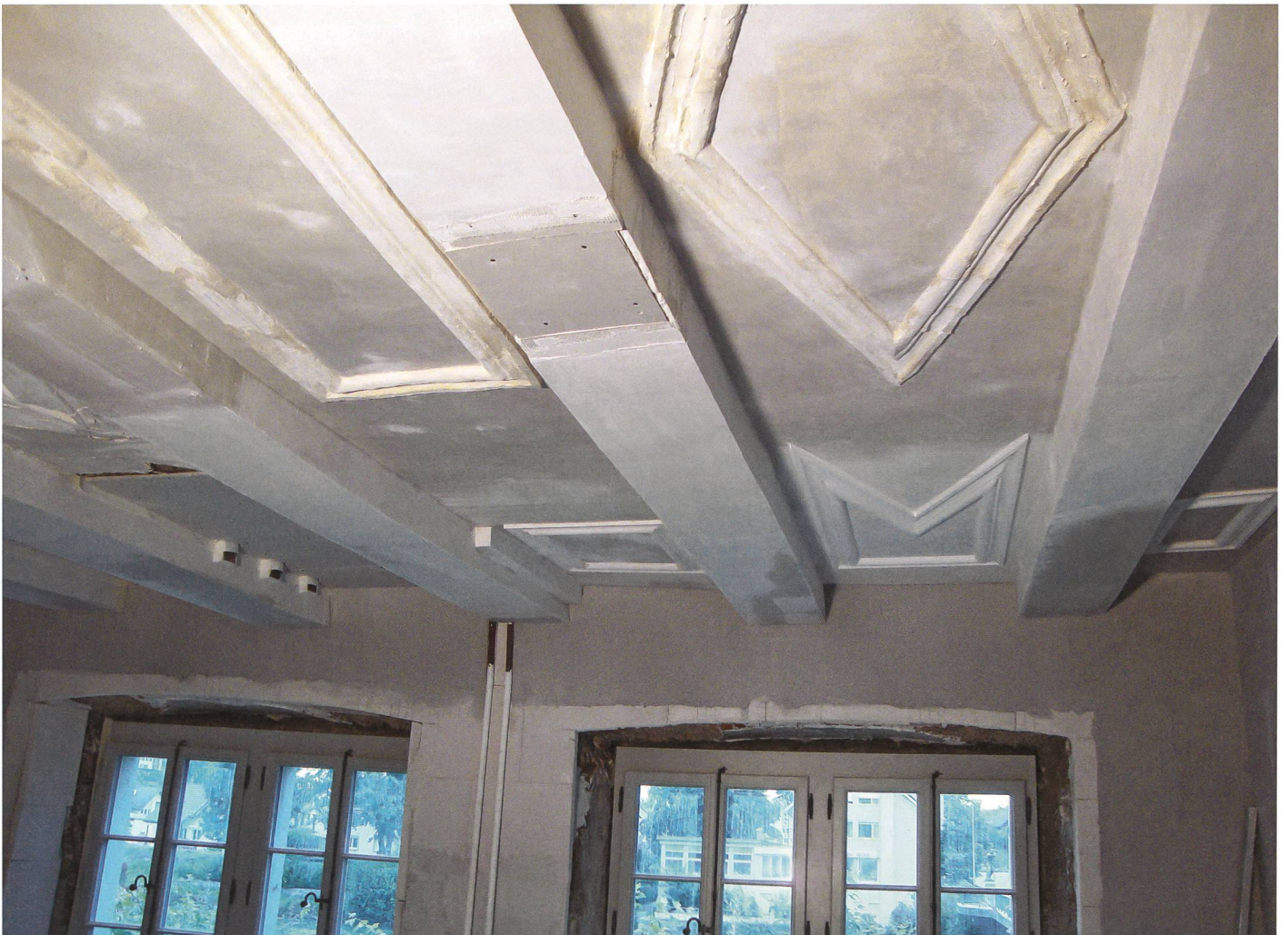
Tanzsaal, Stuckdecke in Bearbeitung
