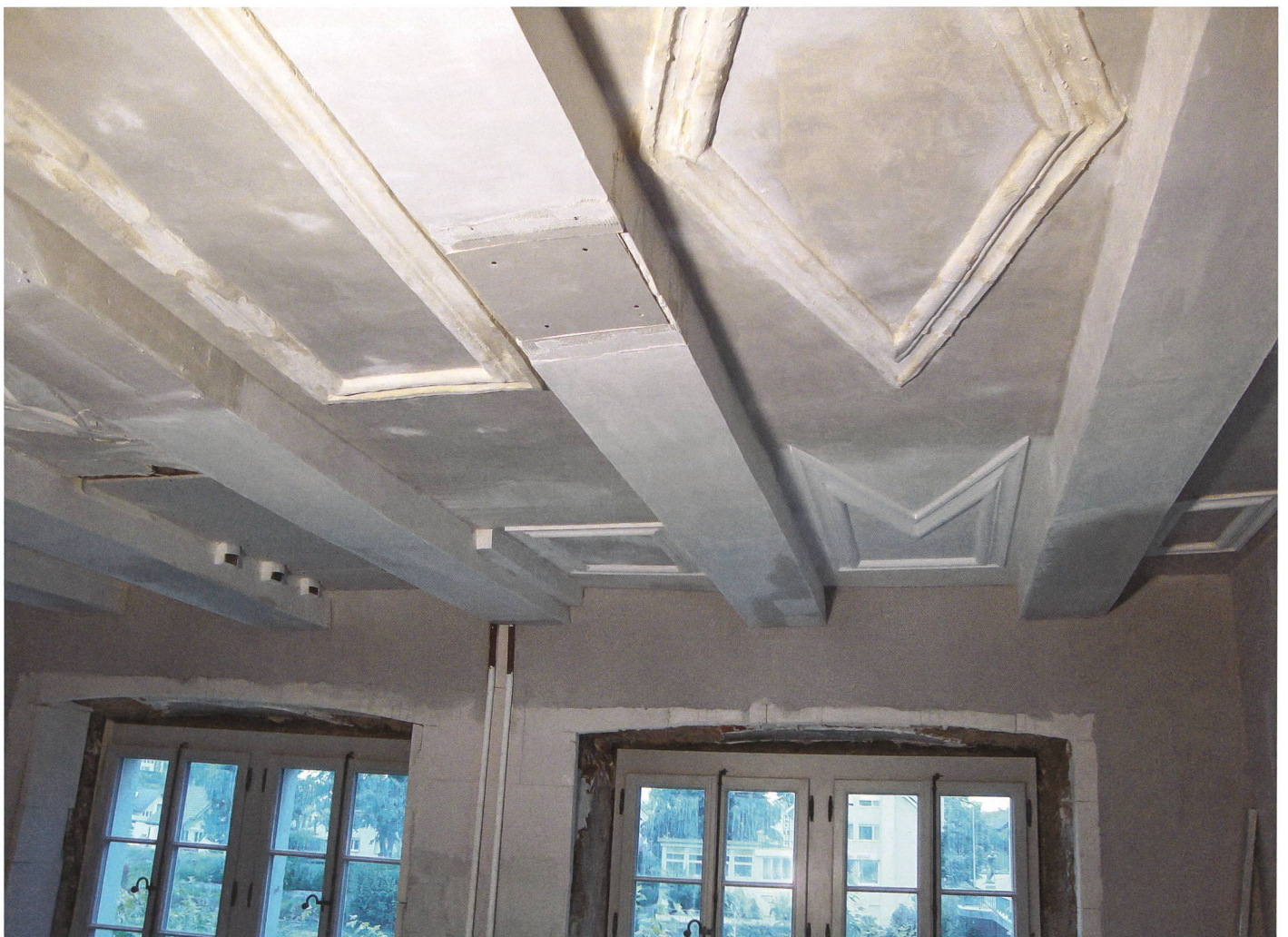
Tanzsaal, Stuckdecke in Bearbeitung
