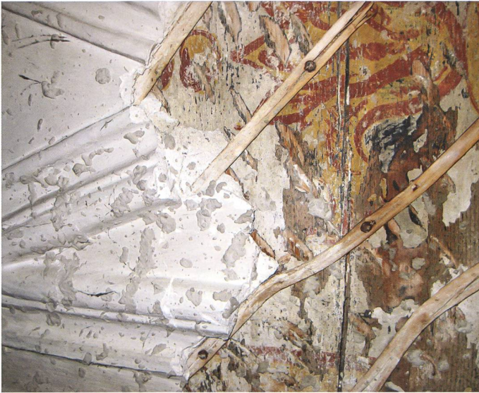
Tanzsaal. Die vierfarbige Malerei unter der Stuckdecke, unter der die ursprüngliche Grisaillemalerei von 1570 liegt
