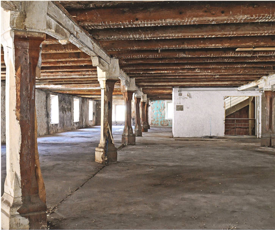
Blick in einen Teil der ehemaligen «Kornschütte» (2. Stockwerk). Die zuvor verdeckte Balkendecke und die eichenen Pfeiler sind wieder freigelegt. Die ganze Halle wurde von zwei weiteren Pfeilerreihen (rechts) getragen. Im Hintergrund das 1927 eingebaute Treppenhaus. Bei Vollbelegung reichte das hier aufgeschüttete Getreide bis zu den Fenstersimsen und musste regelmässig belüftet und umgeschaufelt werden Foto: Marcel Werren, Brugg
