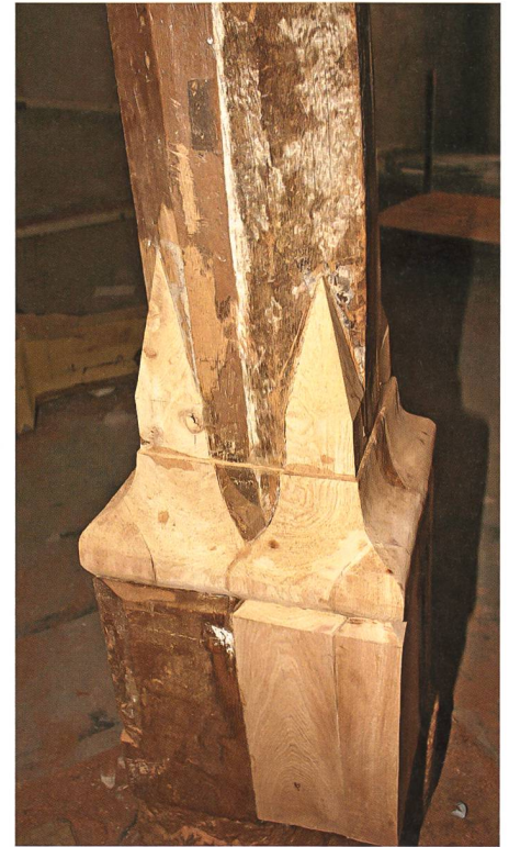
Detailansicht eines Eichenpfeilers 2010. In den 1950er-Jahren rücksichtslos abgesägte Teile wurden nun sorgfältig ergänzt
