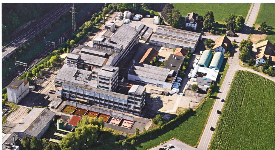
August 2010: Ein letztes Mal vor Abbruchbeginn sticht der Fabrikkomplex der Reichhold Chemie ins Auge Foto: Peter Belart, Aargauer Zeitung
