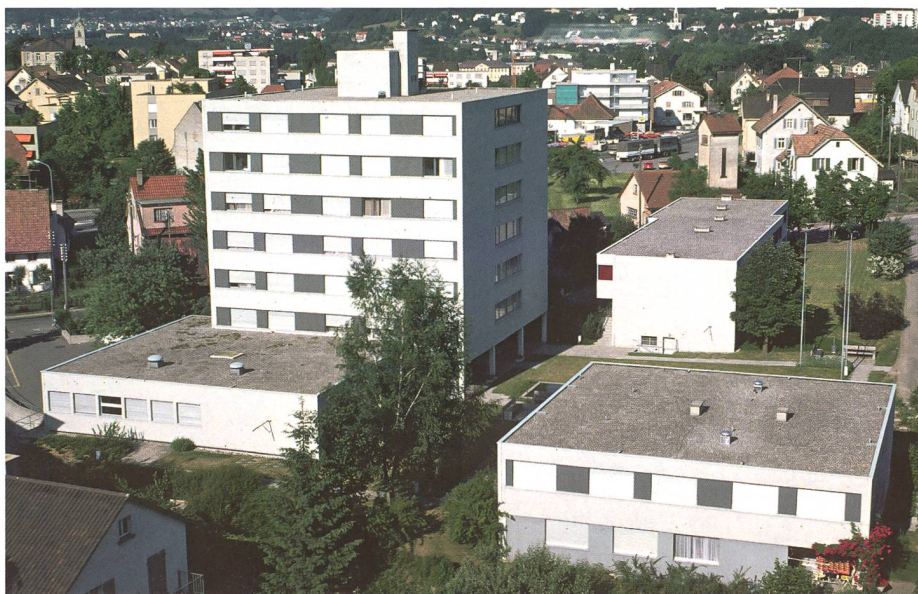
Aussenansicht Altersheim/Wohnungen: das Heim in den 1970er Jahren. Im Rahmen der Erweiterung und Sanierung wurde das Personalhaus (rechts unten) abgebrochen. Foto: Casimir Schöffler
