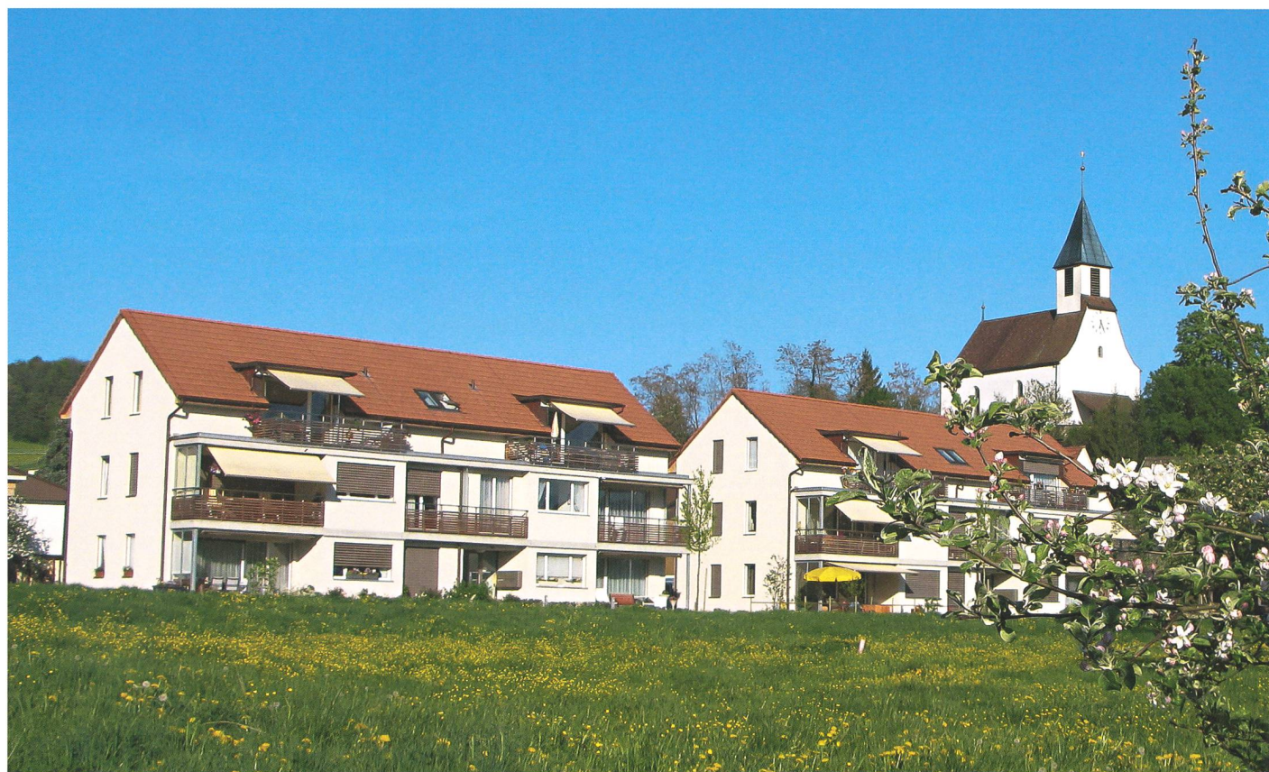
Alterswohnungen: Die ersten beiden Häuser der Genossenschaft «Wohnen im Alter». Auf der Wiese im Vordergrund sind bereits die nächsten zwei Häuser im Bau.
