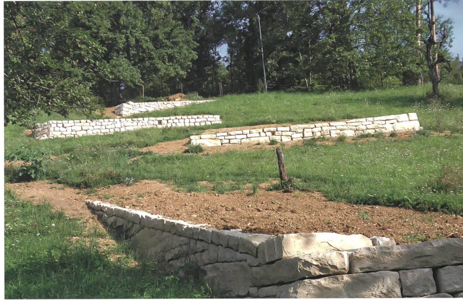
Trockenmauerbau
