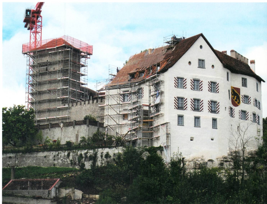
Das Schloss Wildenstein wird umfassend saniert. Foto: Peter Belart
