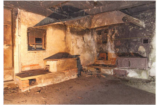
Abbildung 15. Die Küche im Kernbau des Dahlihauses. Die beiden Sparherde und die Rauchhurd stammen aus dem 19. Jahrhundert.
