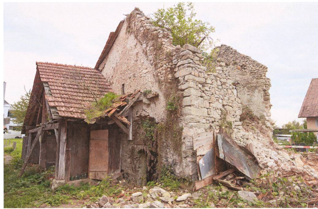
Abbildung 6. Der mehrfach umgebaute, inzwischen halb zerfallene Speicher mit Gewölbekeller. Foto: Theo Frey, Kantonsarchäologie Aargau
