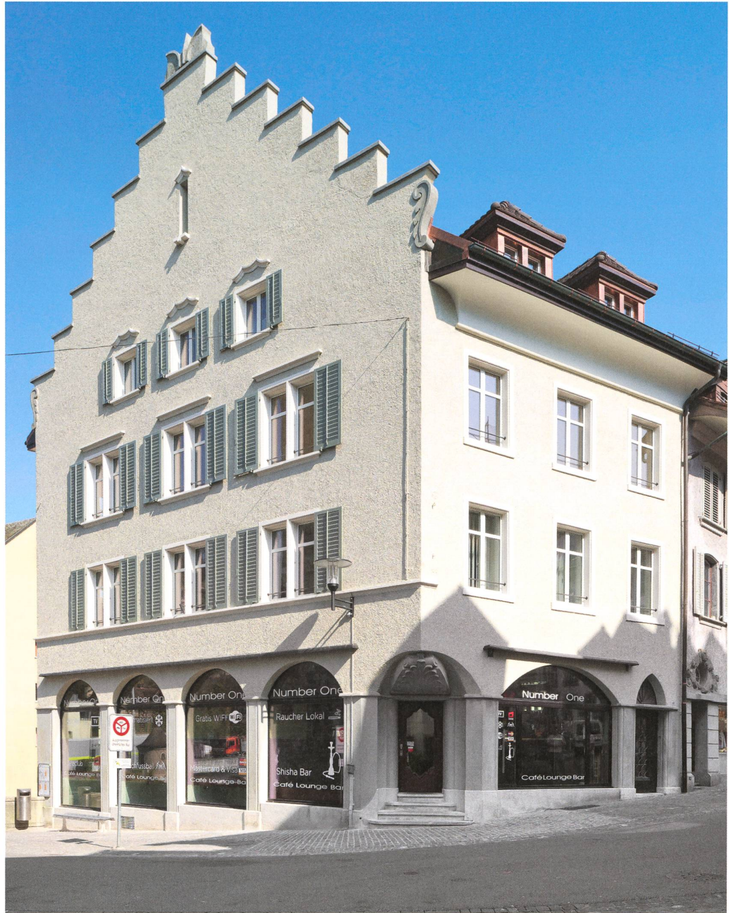
Das Haus Hauptstrasse 66 im Jahr 2014 nach der Sanierung durch die Genossenschaft Altstadt Brugg. Bild: Peter Munz
