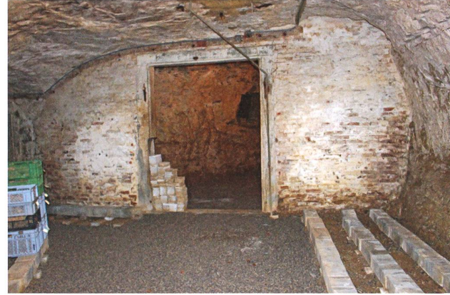
Blick in den kleineren, zweiseitigen Felsenkeller
