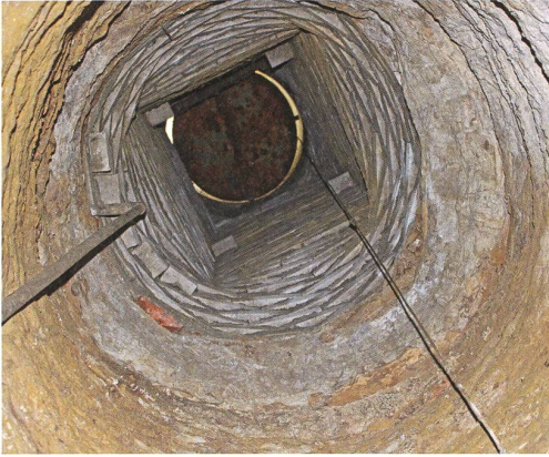
Der Belüftungsschacht führt senkrecht nach oben.
